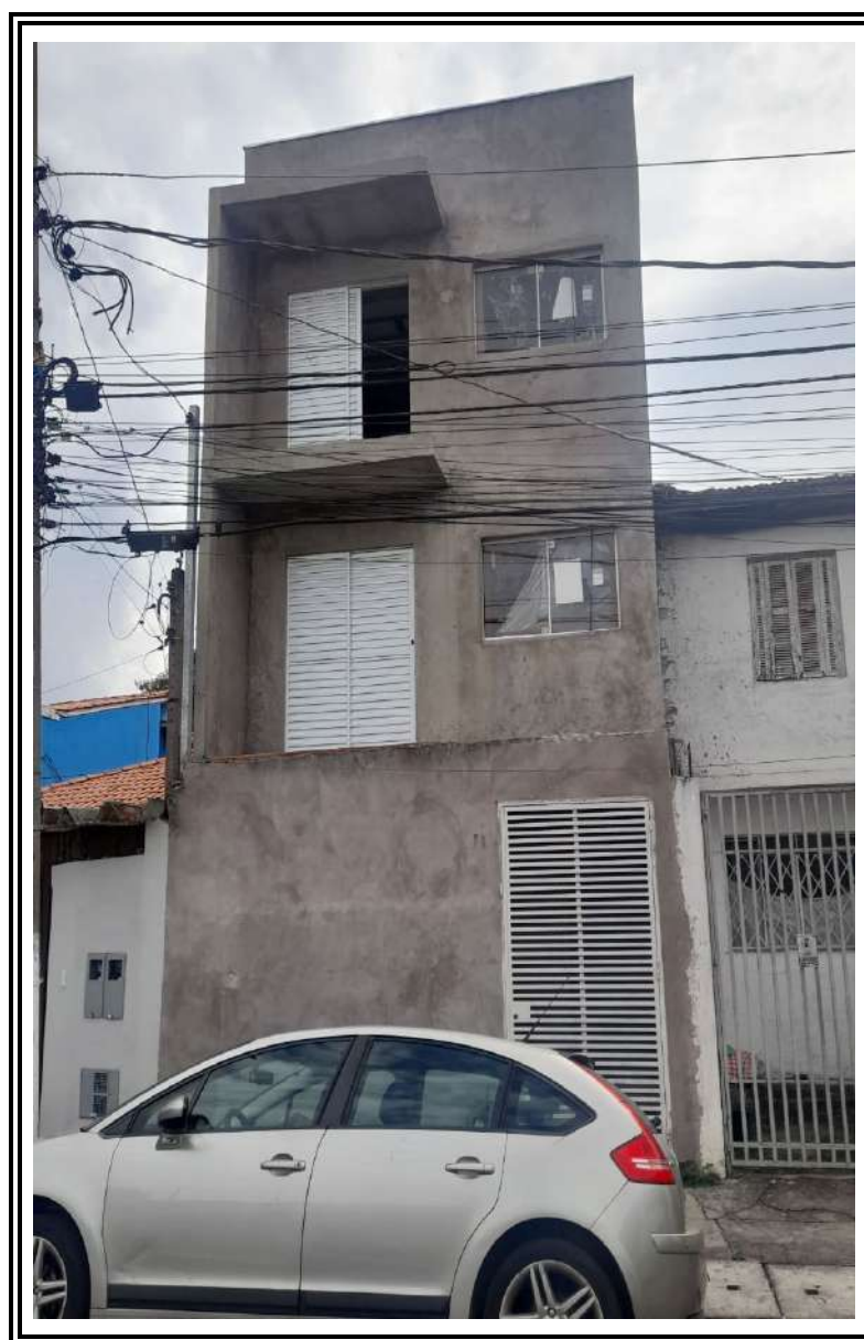
Foto nº 01: Vista geral do imóvel em avaliação
