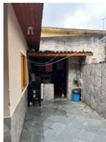
Foto 10 - Vista da lavanderia do imóvel.
