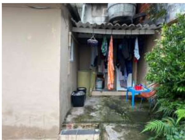
Foto 13 - Vista da lavanderia da edícula.
