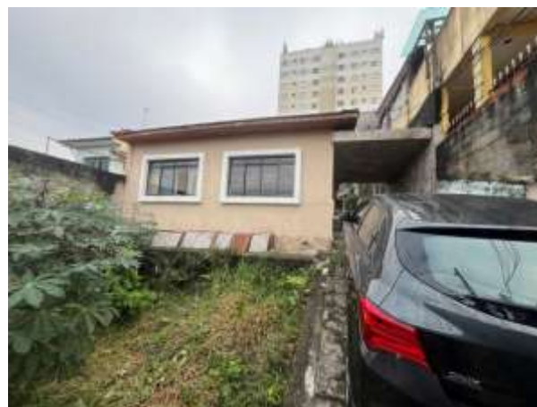
Foto 2 - Vista da fachada frontal do imóvel.
