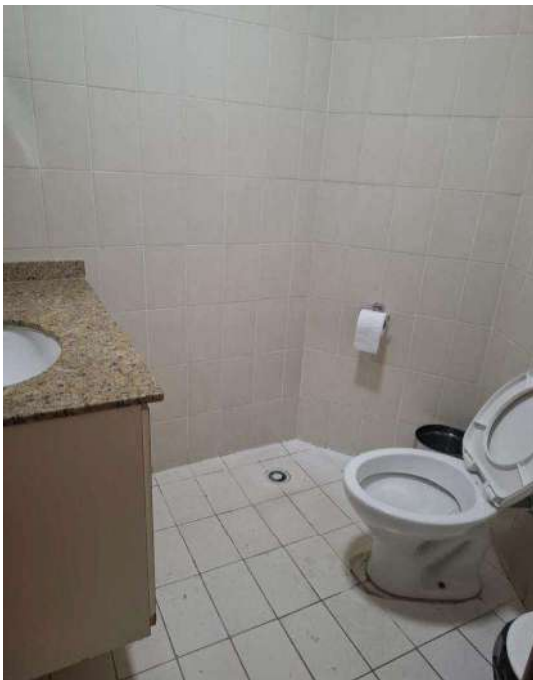
Foto 11 - Banheiro Salão de Festas
