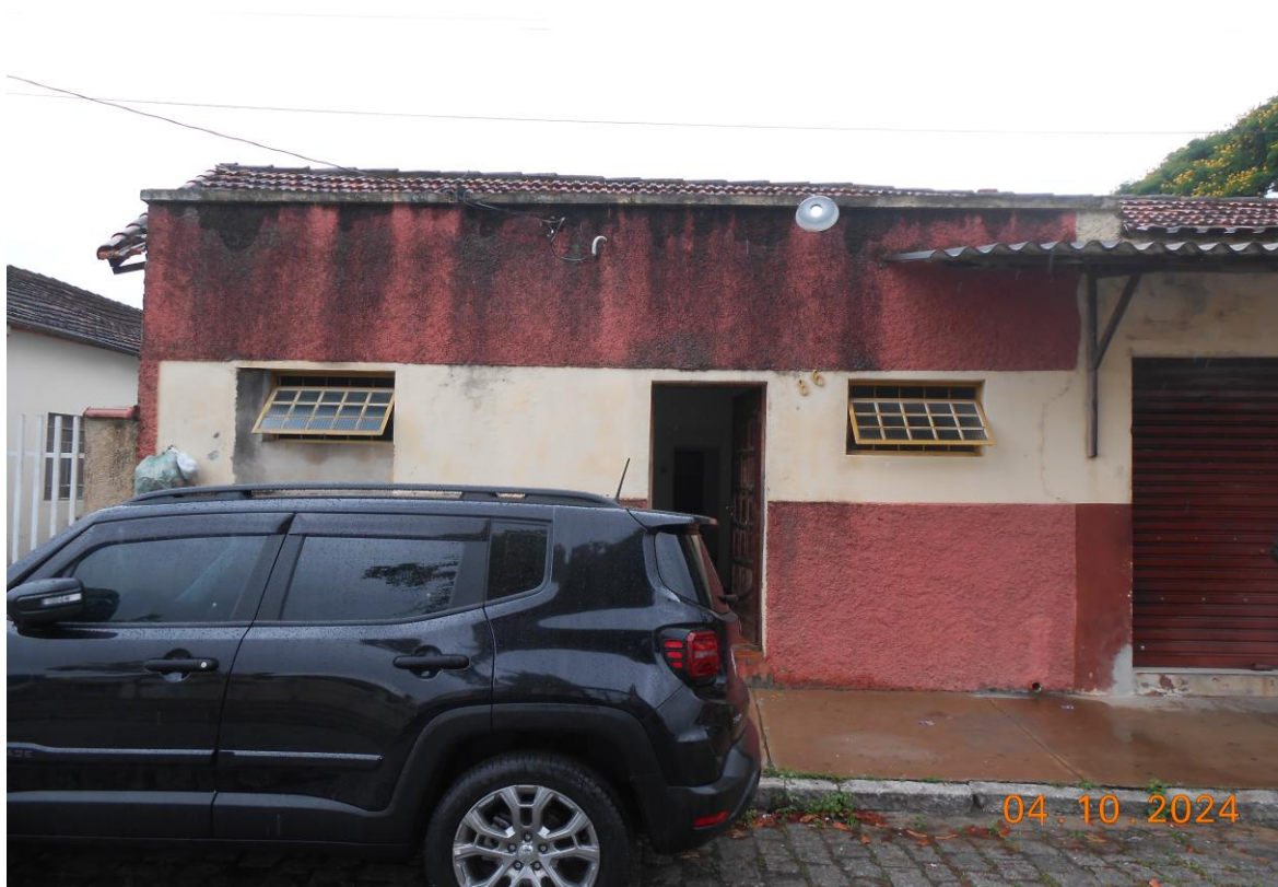
Foto 7: Vista frontal do imóvel de matrícula nº.12.418 na Rua Capitão Nelcy Rocha Pires, nº.86, Vila Canevari, Cruzeiro-SP.
