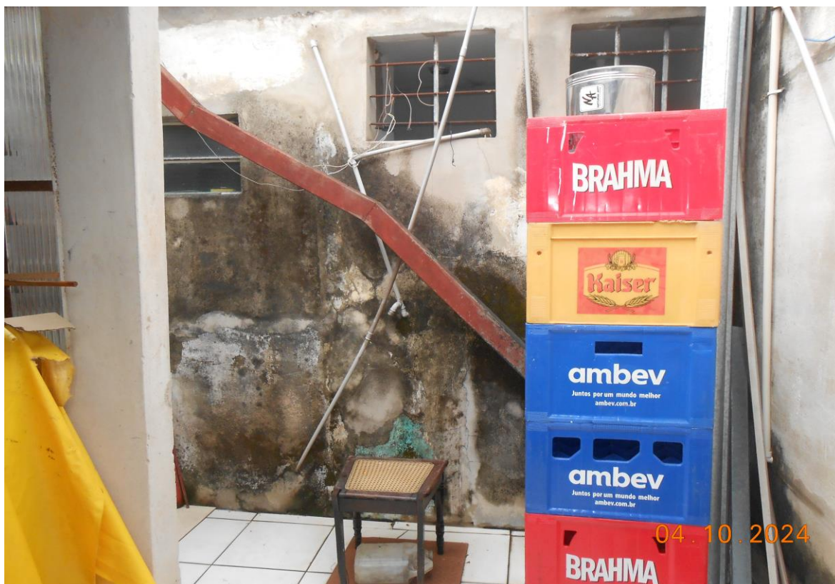
Foto 5: Vista do quintal do imóvel de matrícula nº. 8533.
