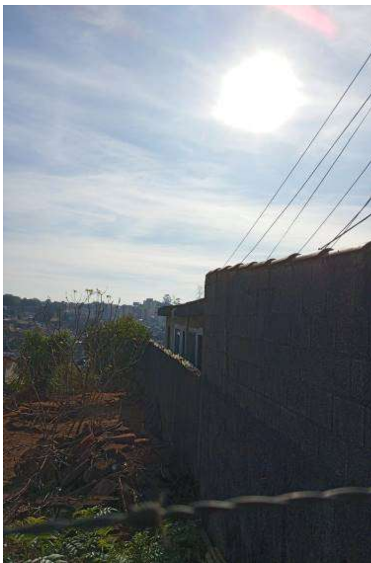
FOTO nº 08 Vista do geral do imóvel, na divisa com o lote 08, à direita.
