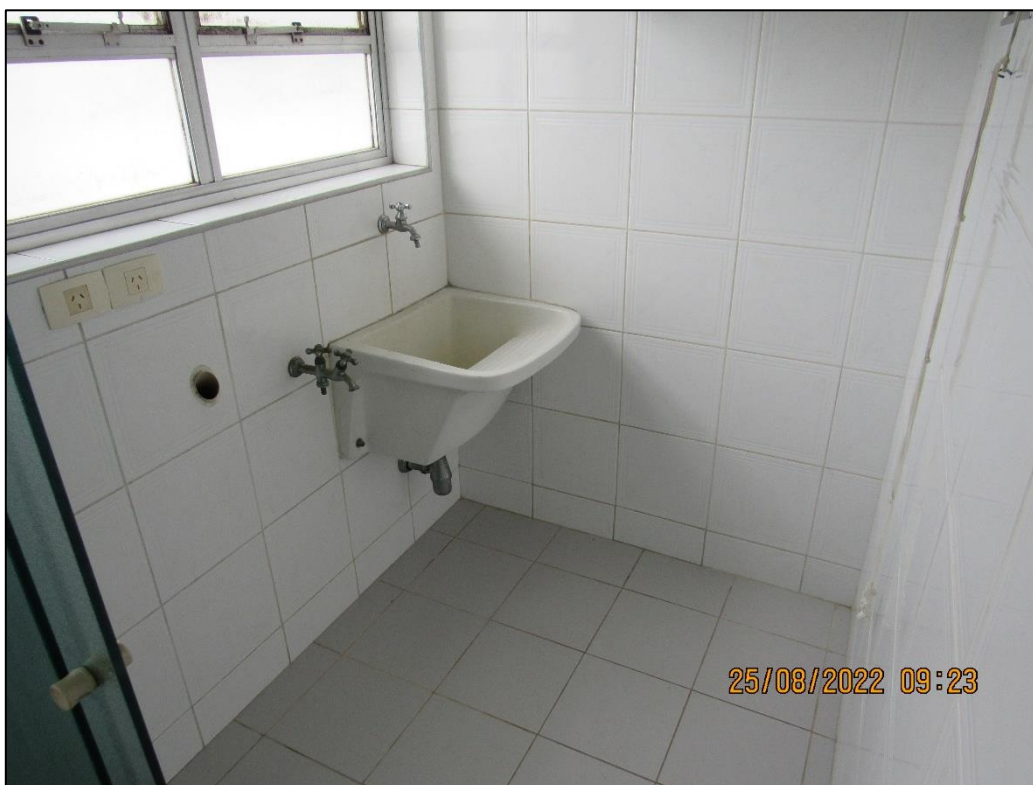
Foto 11 – Vista da área de serviço - (Situação Paradigma Unidade Nº 53).
