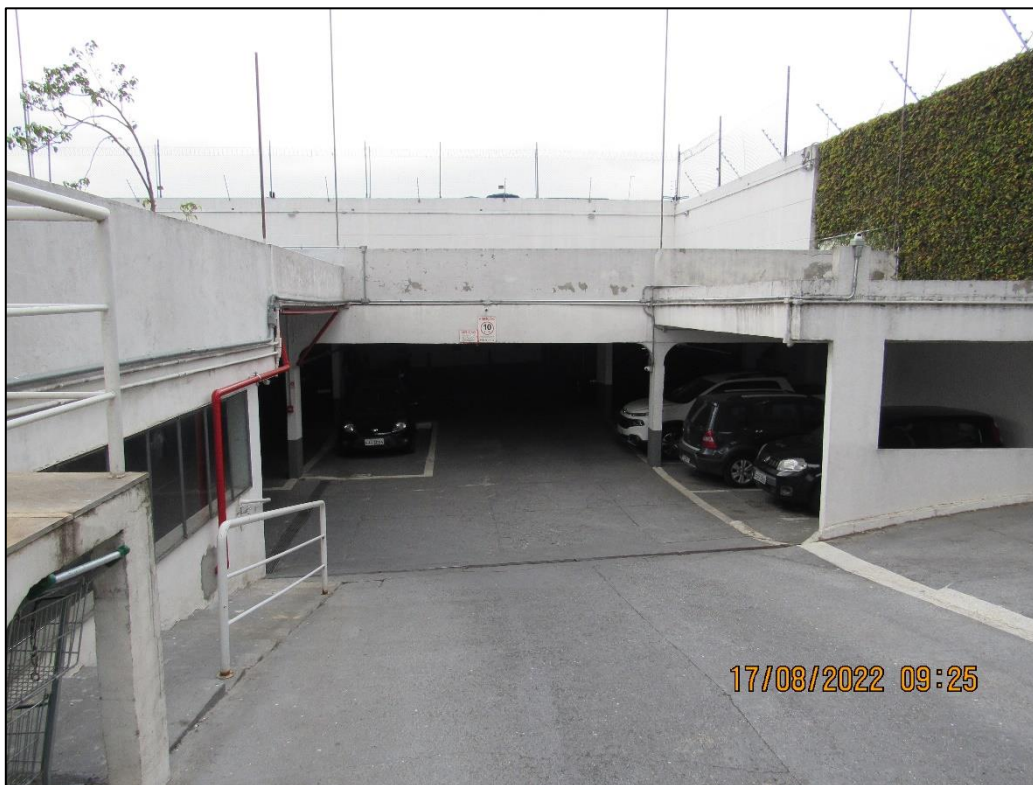
Foto 5 – Vista da garagem.
