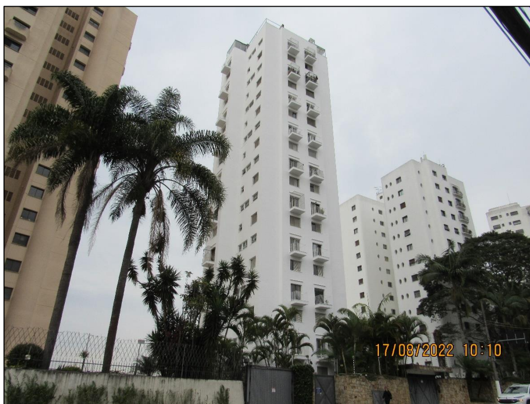
Foto 1 – Vista da fachada.
