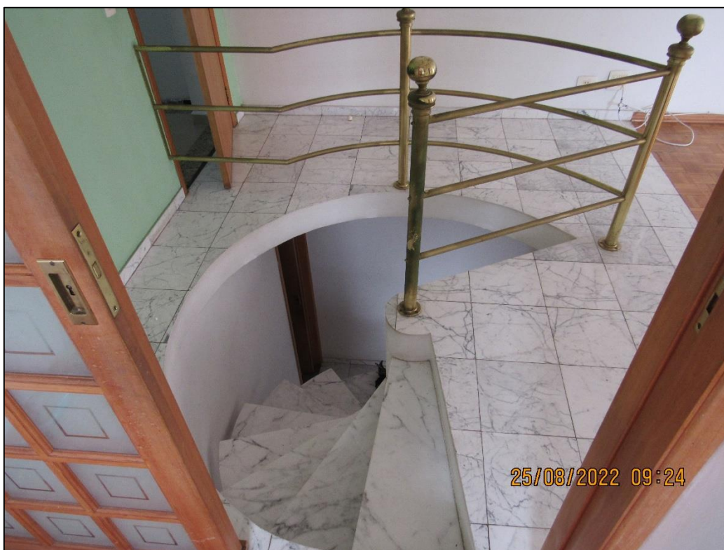
Foto 12 – Vista do acesso ao pavimento inferior - (Situação Paradigma Unidade Nº 53).
