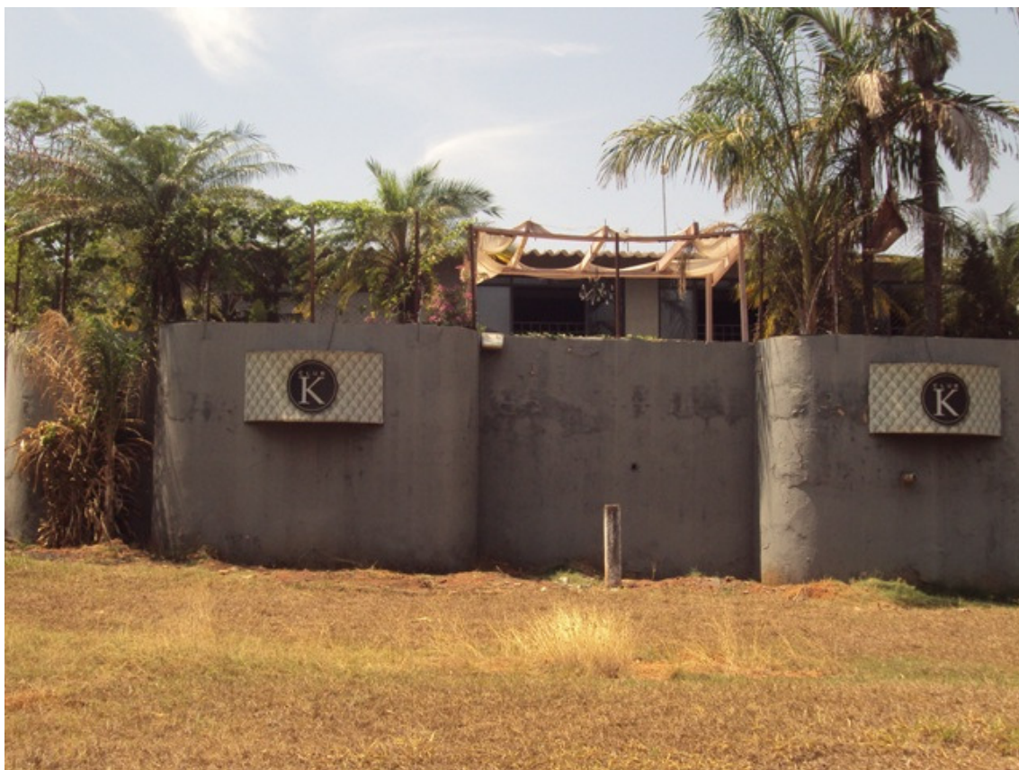
FOTO 05 – Vista da construção.
