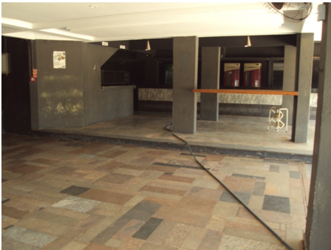
FOTO 13 – Vista do pavimento térreo internamente.
