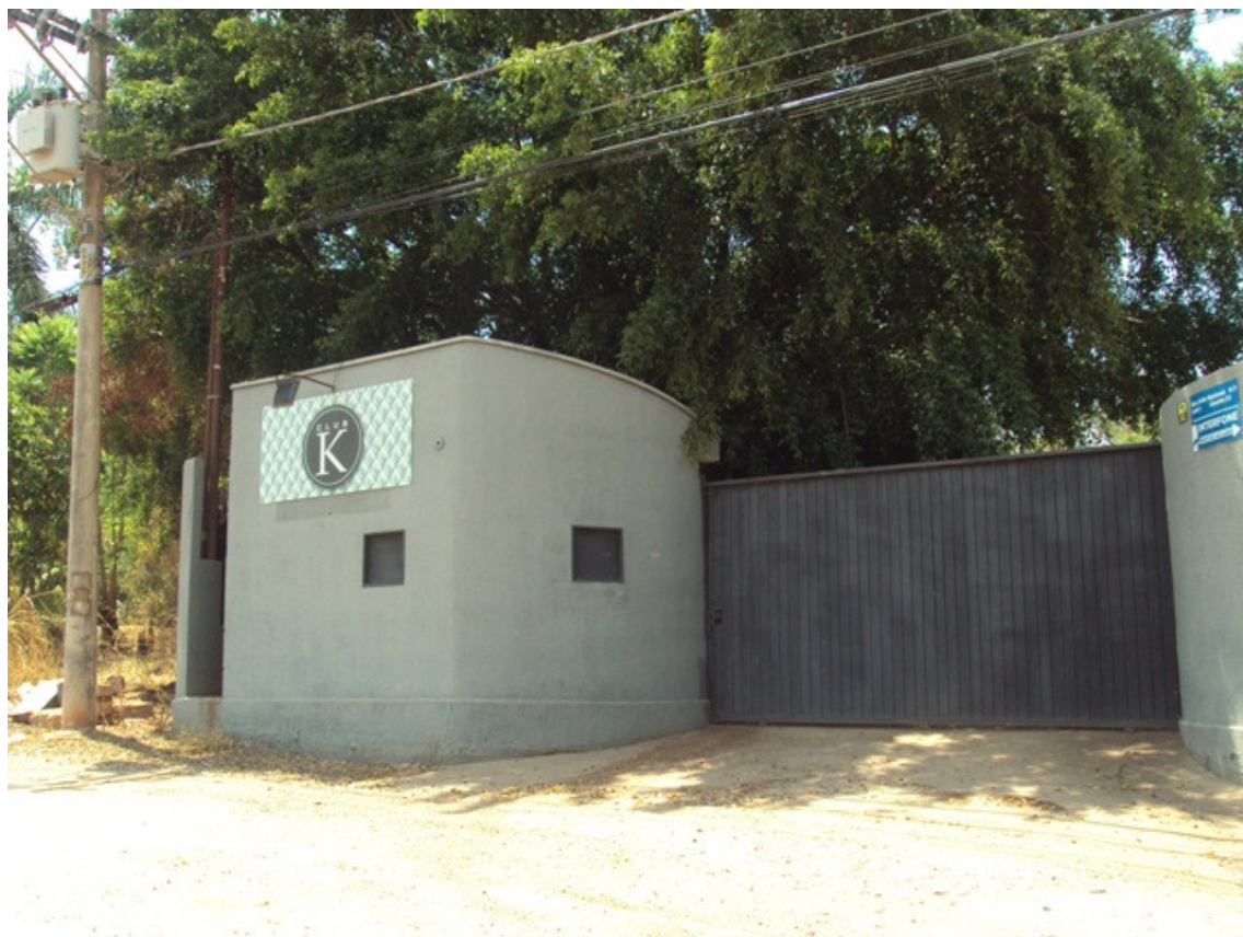
FOTO 01 – Imóvel localizado na Rua João Benhossi nº 7 – Vila Toninho.
