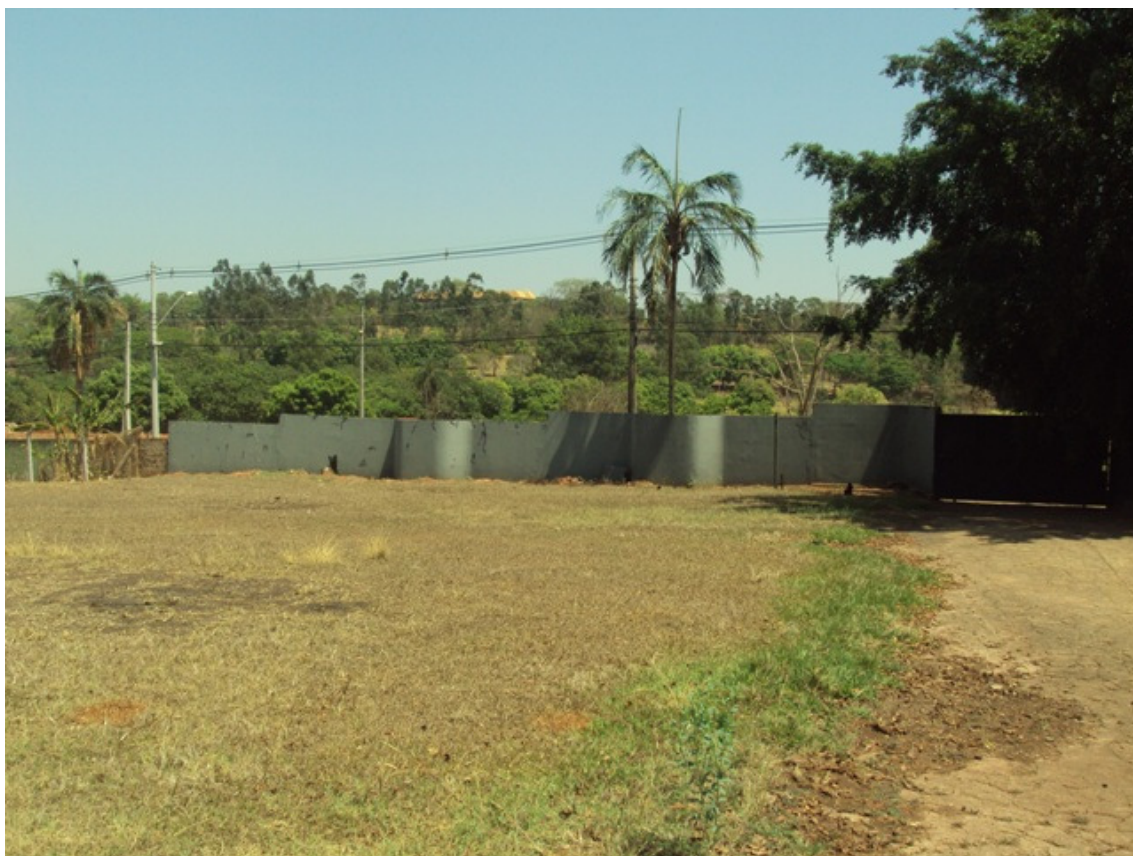
FOTO 15 – Muro da frente visto pelo lado de dentro do imóvel.
