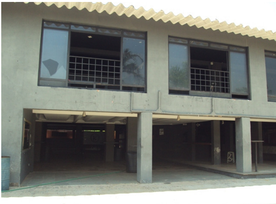
FOTO 12 – Vista do mezanino e pavimento térreo.
