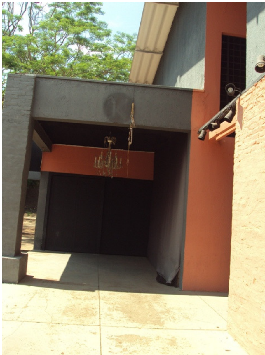
FOTO 07 – Vista da porta de entrada do salão.
