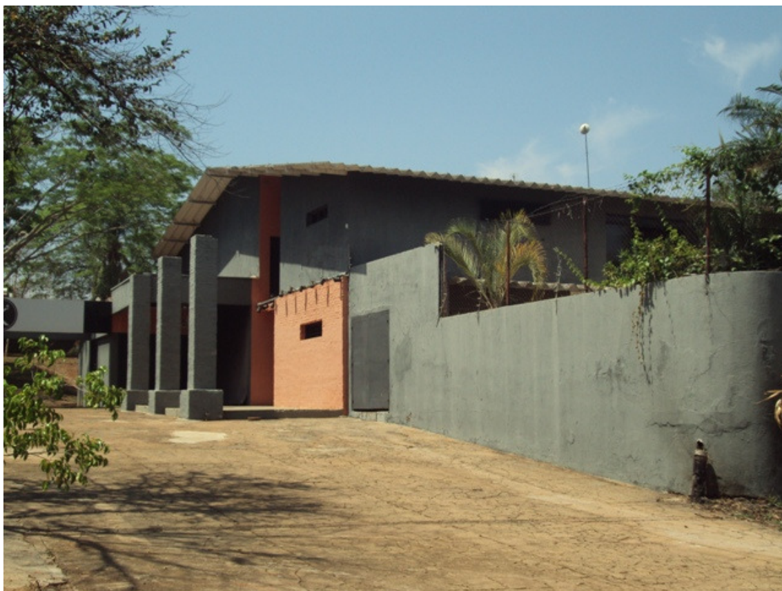
FOTO 08 – Visão da construção.
