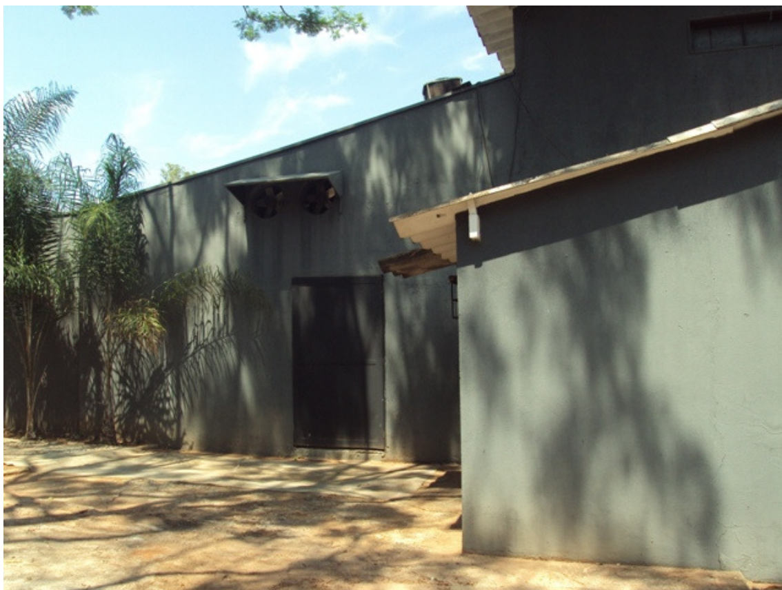
FOTO 09 – Vista dos fundos da construção.
