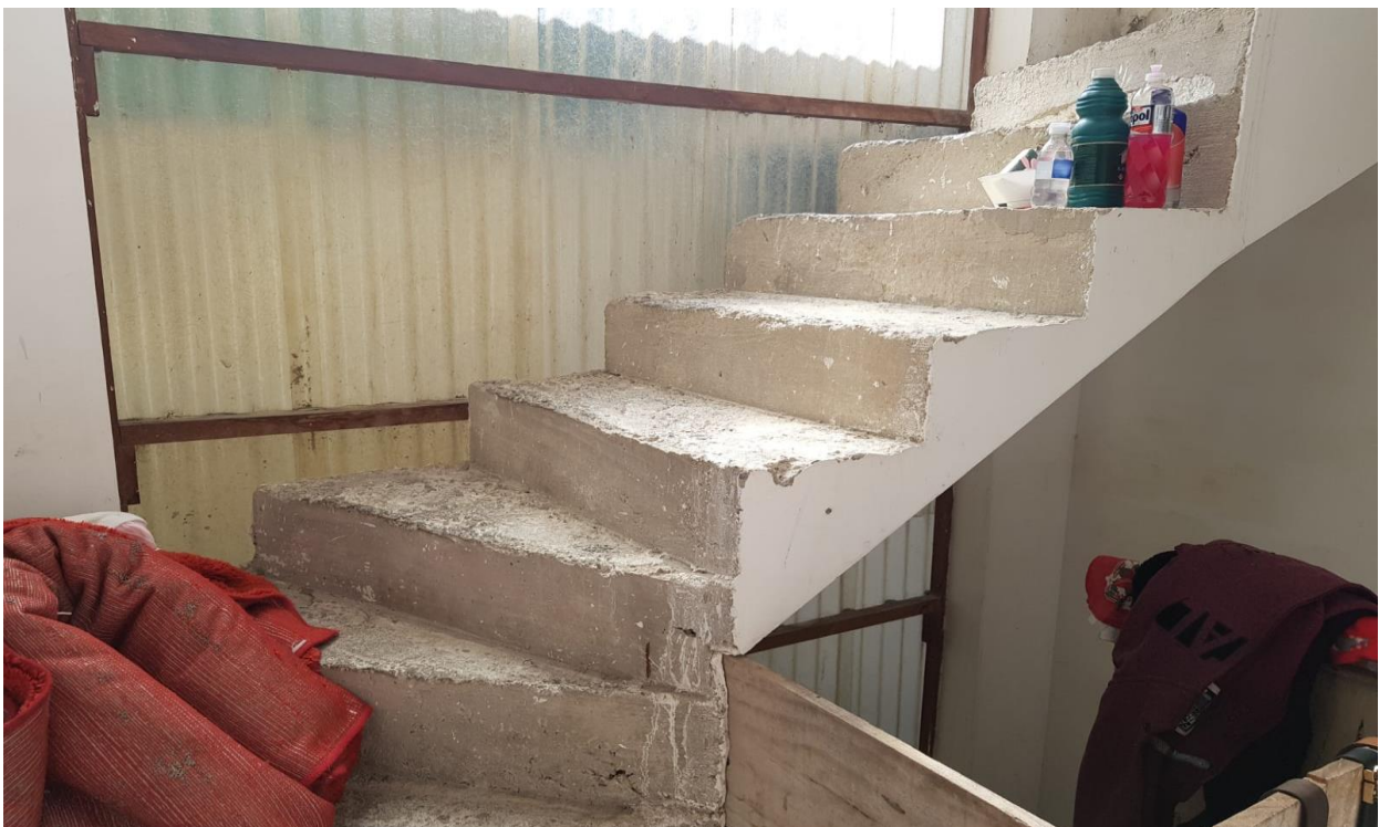
Foto 27 – Escada de acesso à área de serviço
