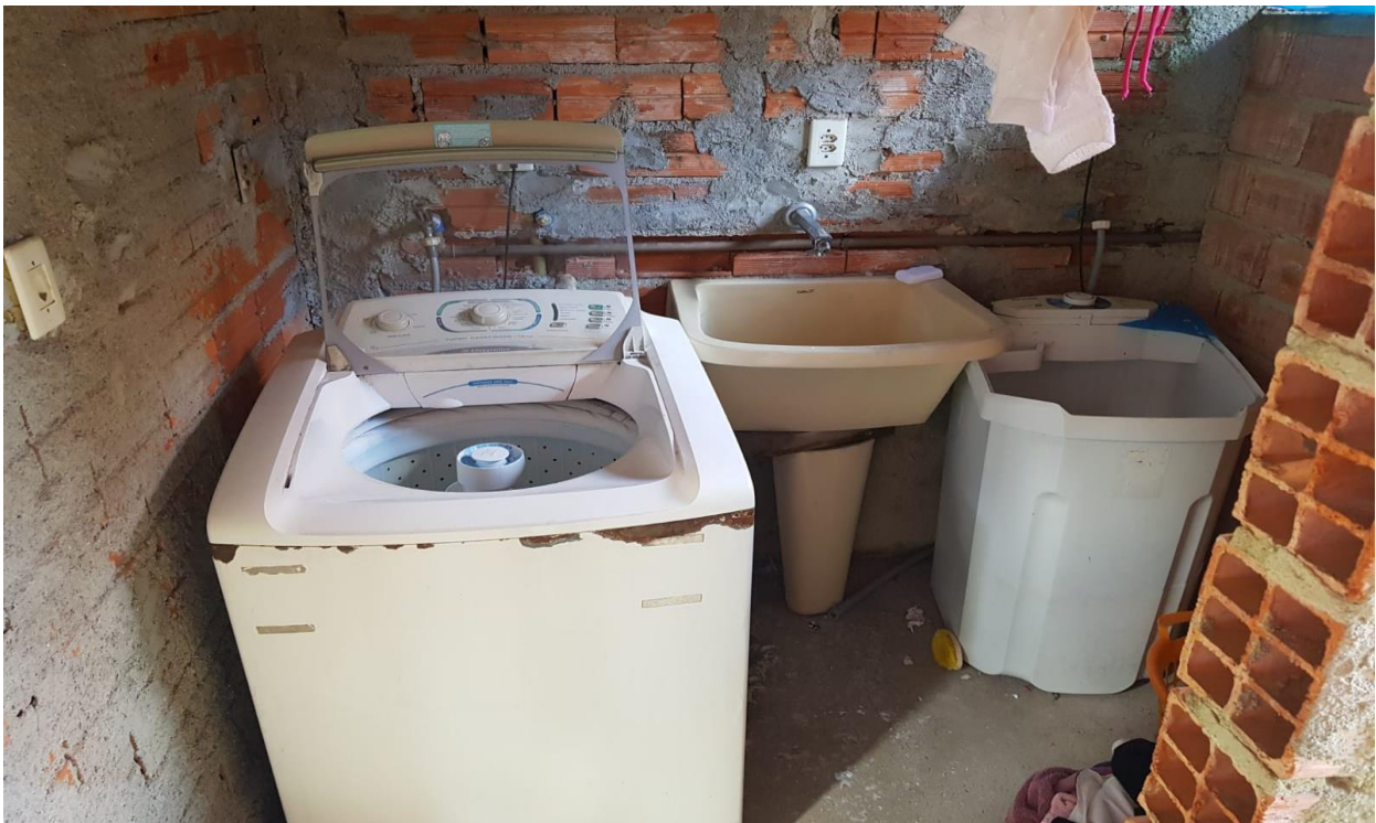
Foto 29 – Área de serviço
