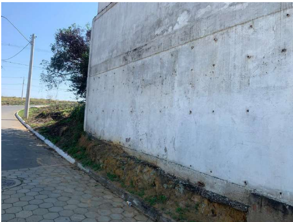
Foto 13 – Detalhe da robustez do Muro de arrimo da vizinha da esquerda.
