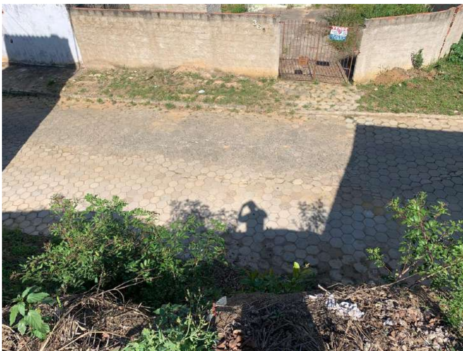
Foto 08 – Vista para a Rua Maria Rosa Betencourt com acentuado acríve em relação ao referido logradouro – Necessidade de Muro de Arrimo e Aterro.
