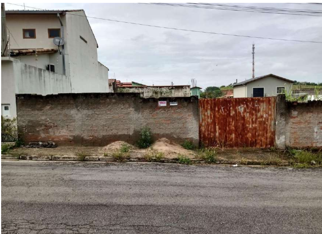
Foto do Elemento 03 – Rua Alfredo Bittencourt – Parque Primavera.
