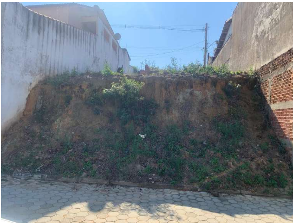
Imóveis Avaliados em 30/08/2024 – Data da Vistoria – Fundos do Terreno – Rua Maria Rosa Bittencourt – Jd. Europa II – acesso à Rua se dá pelos fundos em aclive acentuado.
