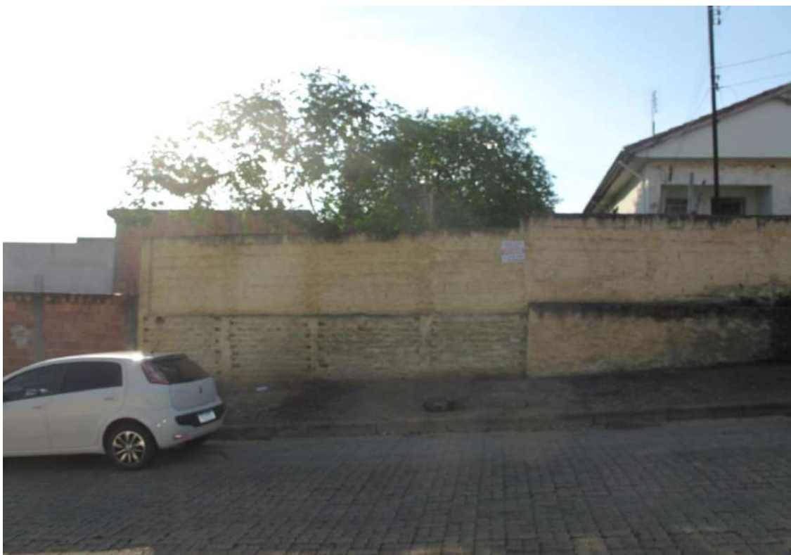
Foto do Elemento 05 – Rua Maria de Freitas Bastos – Parque Primavera.
