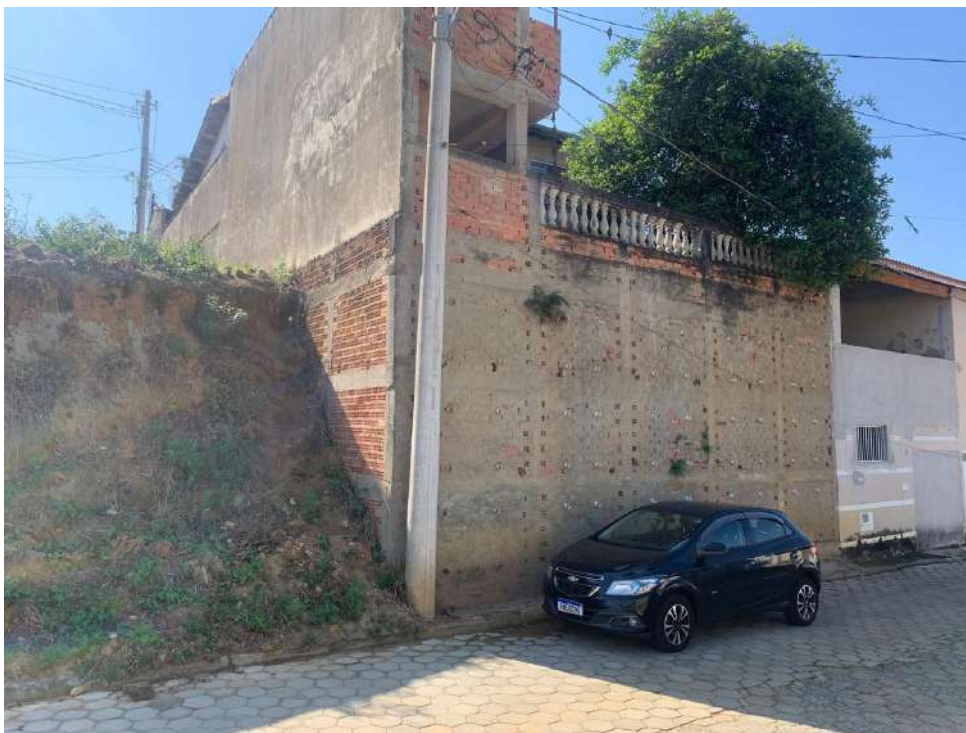
Foto 11 – Muro de arrimo – Vizinho da Direita.
