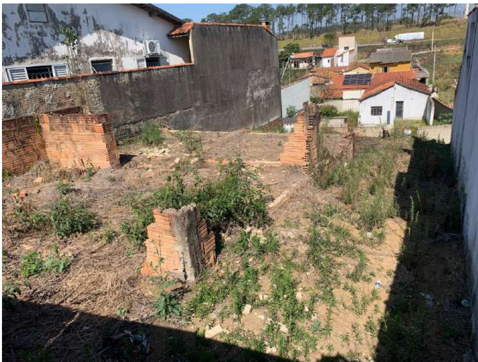
Foto 05 – Vista interna do terreno – Passando pelo portão de ferro – Construção abandonada após fase de fundação (Brocas e vigas baldrame) à esquerda da imagem.
