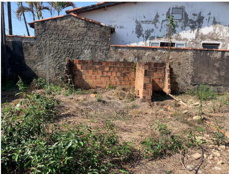
Foto 06 – Após passar pelo portão de entrada – Vista para o confrontante da direita – Trecho de alvenaria erigida (nenhuma utilidade sem projeto e início da obra aprovados pela Municipalidade).
