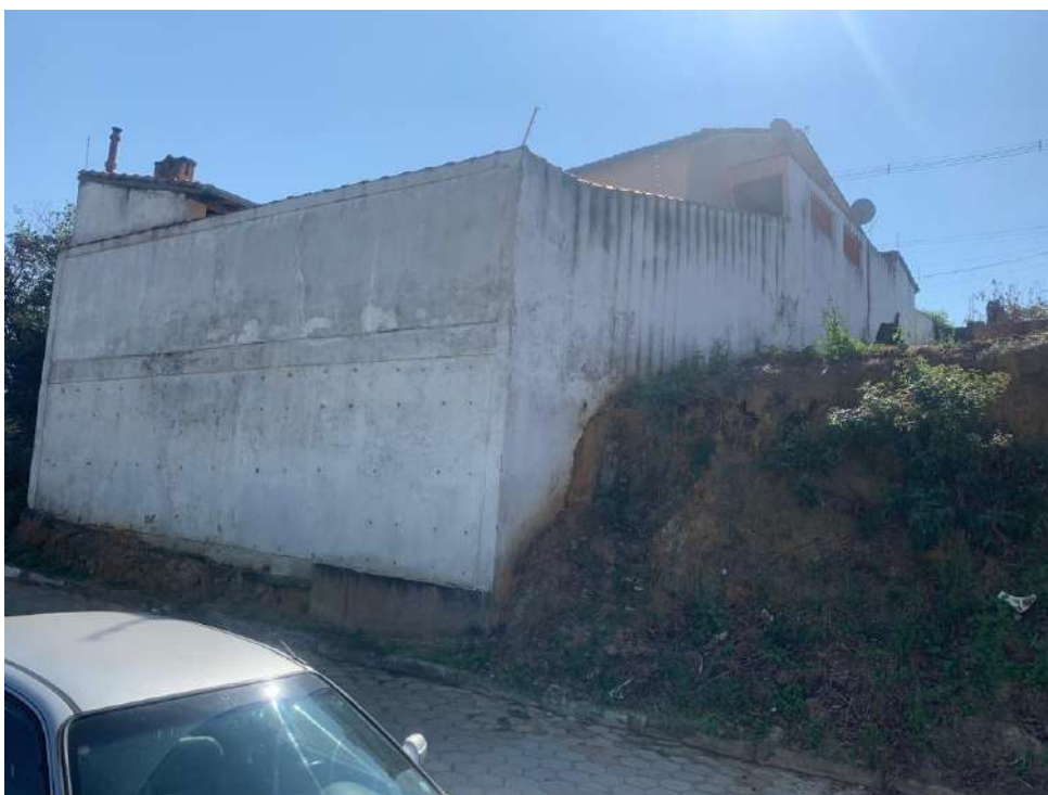
Foto 12 – Muro de arrimo – Vizinho da Esquerda.
