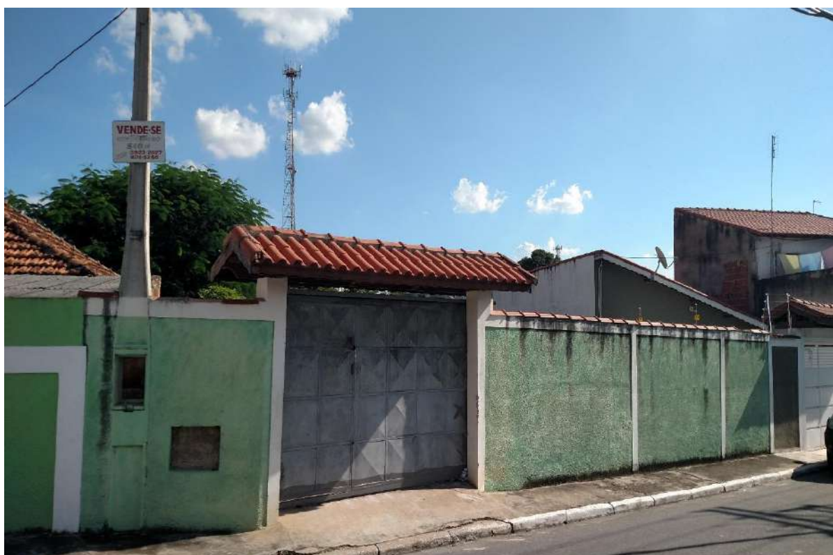
Foto do Elemento 13 – Rua dos Trabalhadores – São João.
