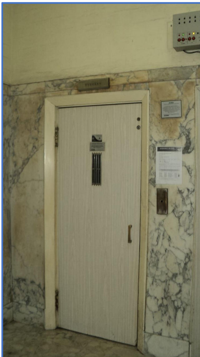
Foto: visão do elevador.
