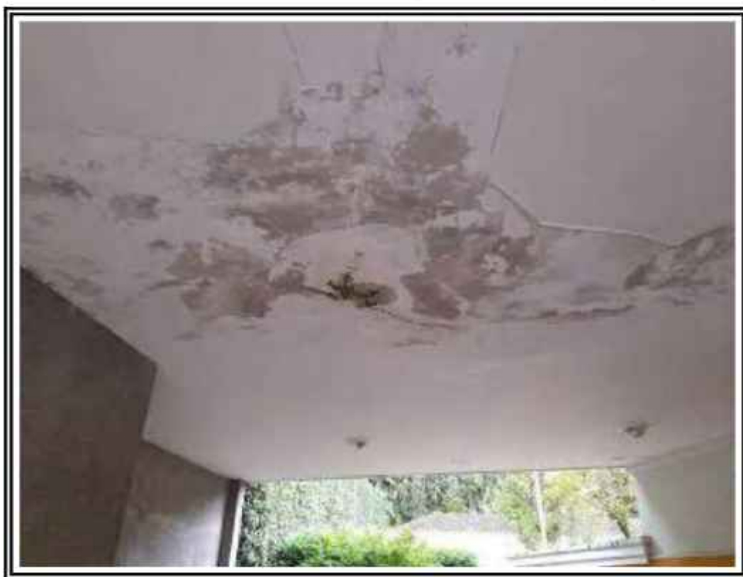
Fotos nº 10 e 11: Detalhes de infiltrações no forro da garagem
