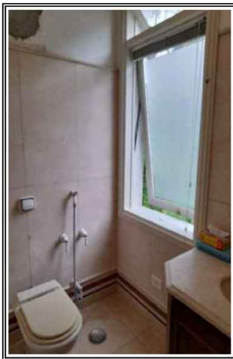
Foto nº 29: Vista do banheiro feminino
