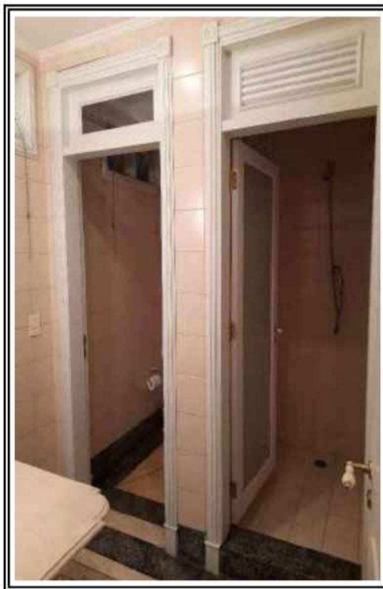
Foto nº 49: Vista da sauna úmida e do banheiro social
