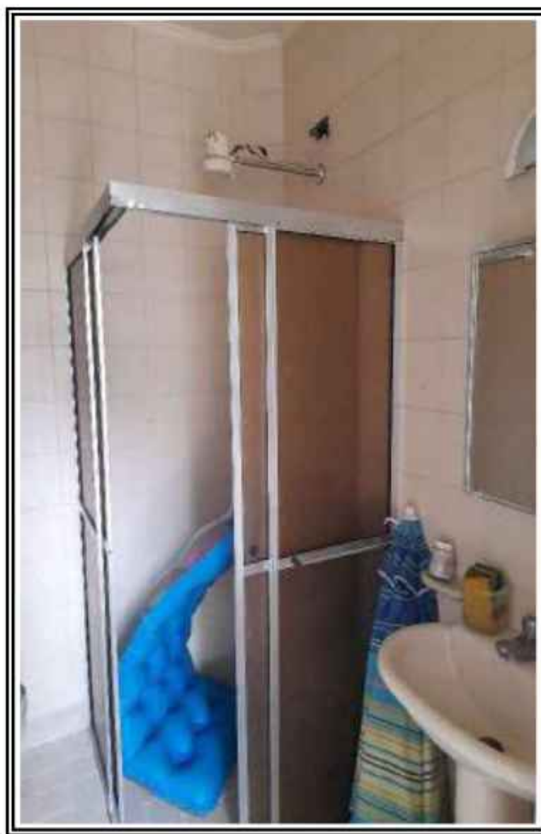
Foto nº 54: Vista do banheiro do dormitório de serviço 02
