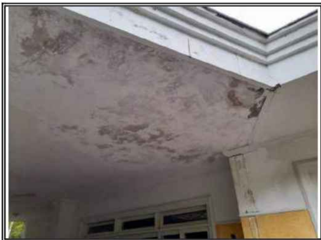
Fotos nº 10 e 11: Detalhes de infiltrações no forro da garagem
