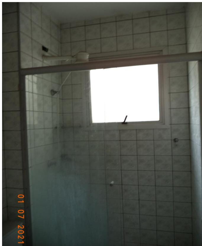
Foto 40 - Box do banheiro
