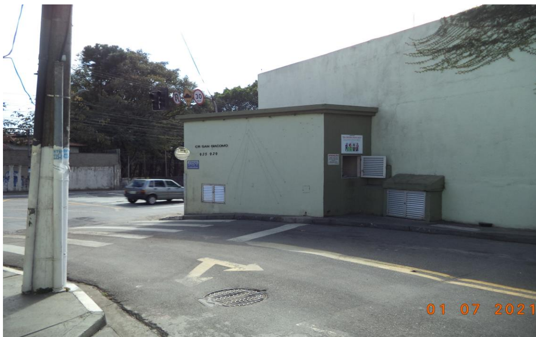
Foto 52 - Acesso ao condomínio vista de dentro do condomínio
