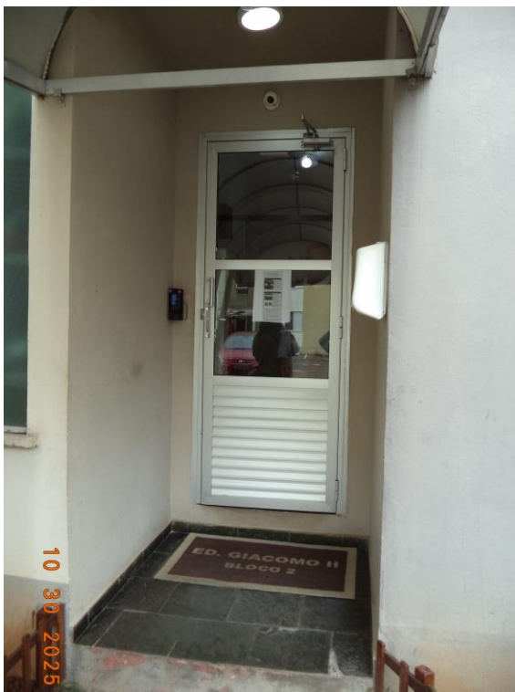
Foto 01 Vista da entrada do Bloco 2
