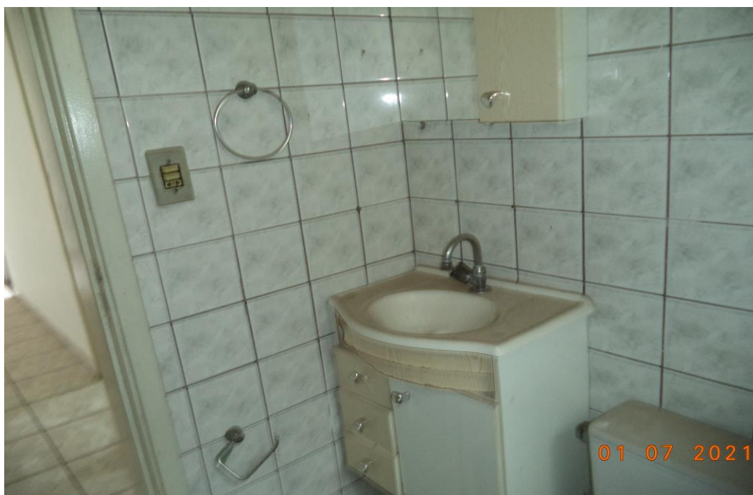
Foto 38 - Banheiro ao lado do segundo dormitório
