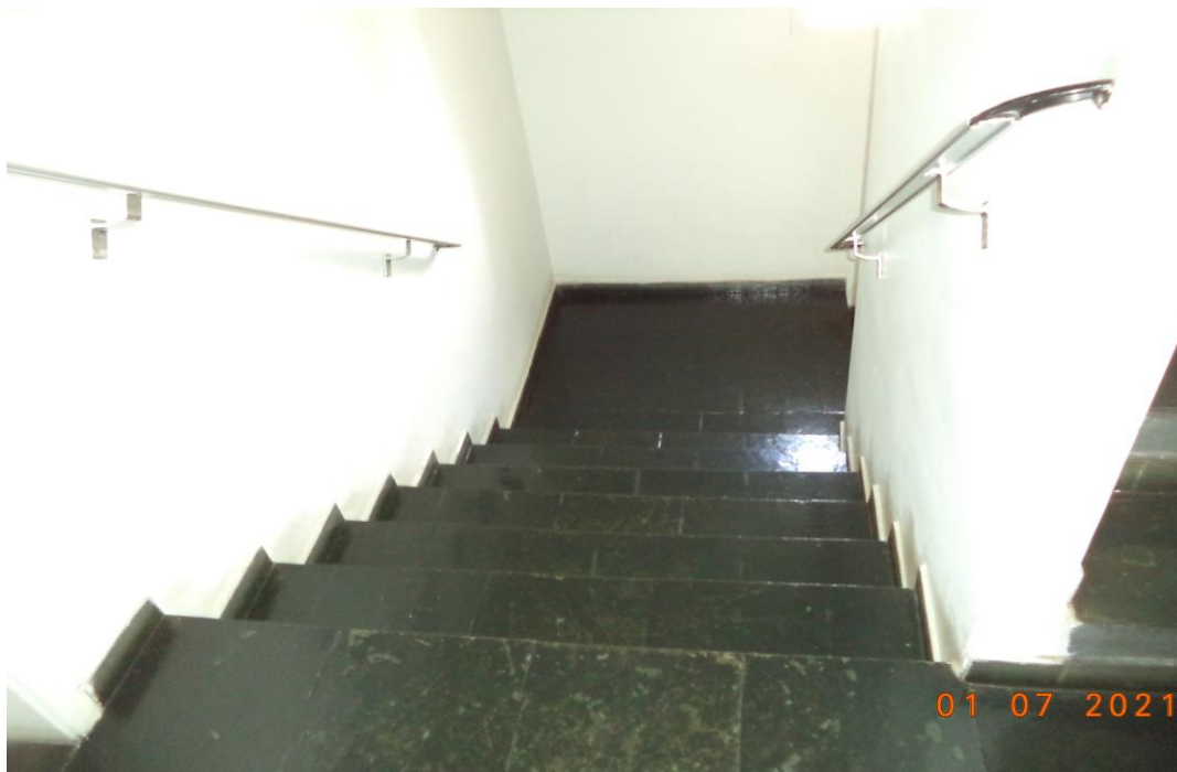
Foto 42 - Escada de acesso aos apartamentos
