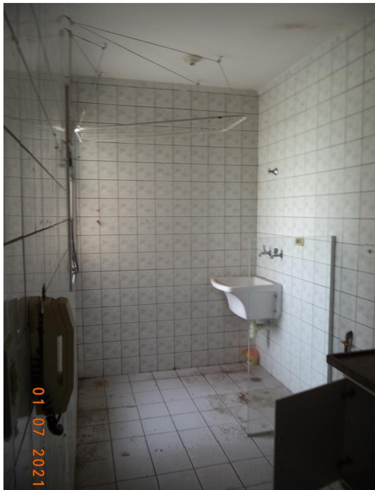
Foto 37 - Vista da lavanderia, contigua a cozinha
