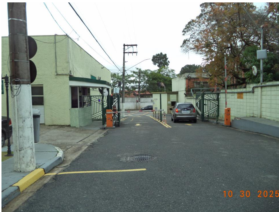
Foto 24 - Vista de dentro do condomínio da entrada/saída
