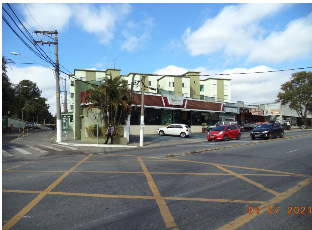
Foto 54 - A esquerda entrada do condomínio vista da Av. do Taboão
