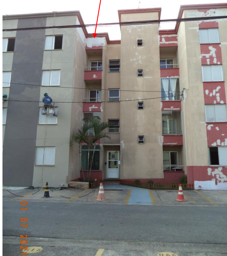
Foto 43 - Fachada do Bloco 2
