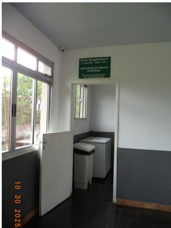
Foto 21 - Entrada da cozinha do salão
