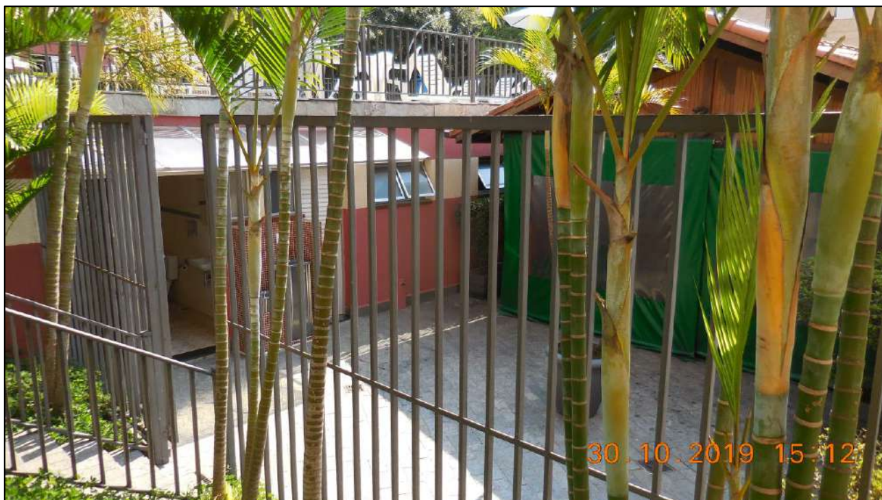
Vista da área de churrasqueira, banheiros e vestiários
