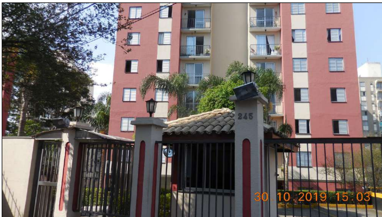
Vista do controle de acesso do Condomínio Parque Botânico e o Edifício Tulipas
