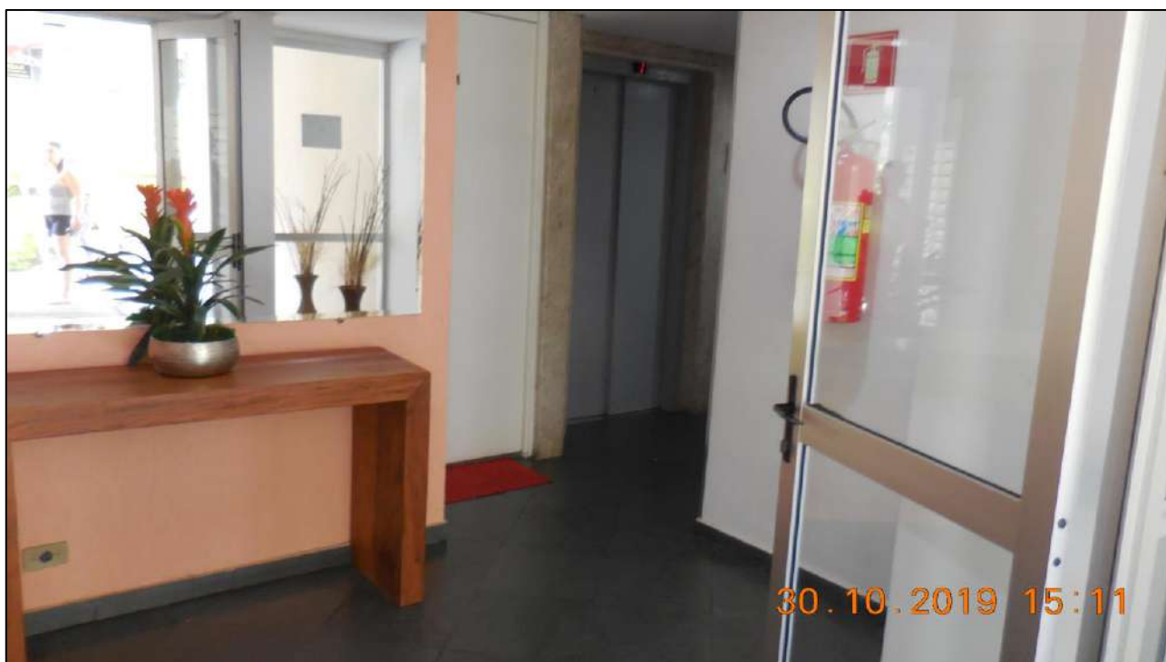
Vista do hall de entrada do Edifício Tulipas
