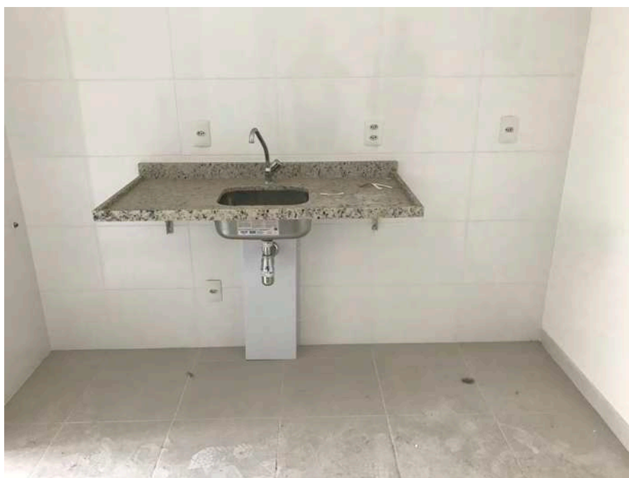
Foto 11- Instalação para kitchinete com piso cerâmico e azulejos ate o teto.
