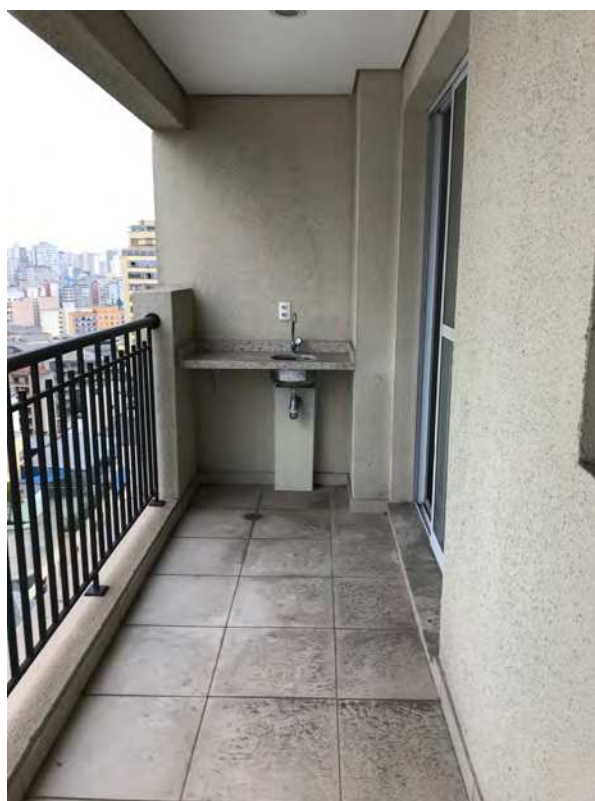
Foto 15- Varanda do Apartamento c/ bancada.
