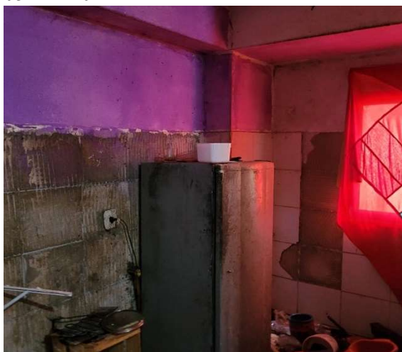
05 vista 02 da cozinha
