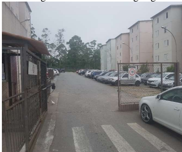
02 vista geral do condomínio e garagens
