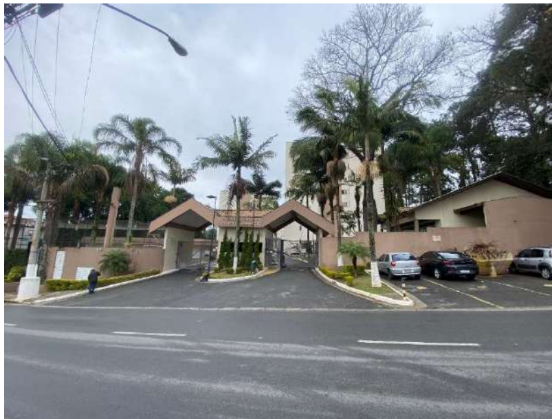
Foto 1 – Vista do acesso ao Condomínio Village Campeste.
