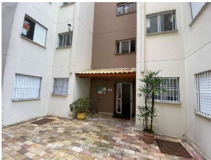
Foto 4 – Vista do acesso ao interior do edifício Paineira.
