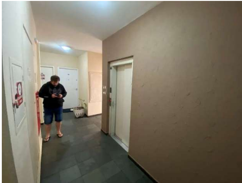
Foto 21 – Vista do elevador.
