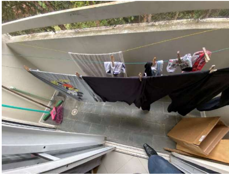
Foto 15 – Vista da sacada da sala da unidade similar nº 71, apresentando os seguintes padrões construtivos: piso em pedra Ardósia; alvenarias em pintura Látex PVA sobre massa texturizada; teto em pintura Látex PVA sobre massa corrida; esquadrias em alumínio.
