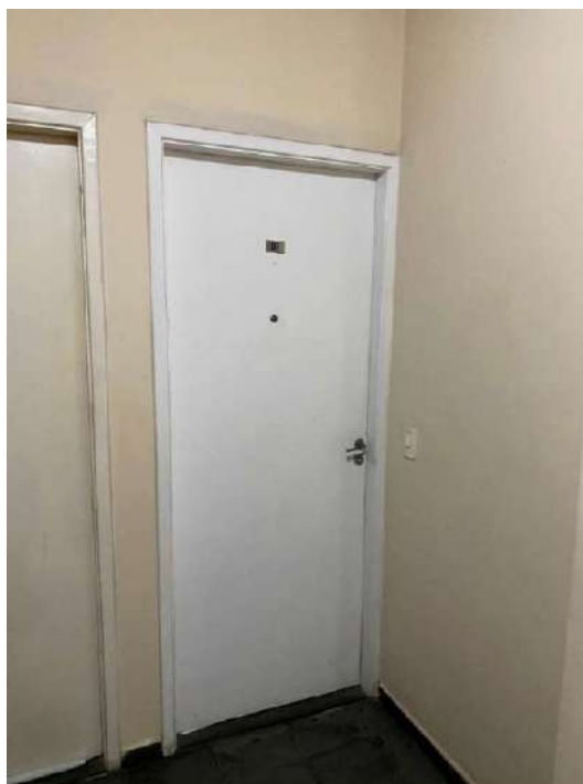
Foto 5 – Vista da porta de acesso à unidade nº 01. Não obtivemos acesso ao imóvel avaliando.
