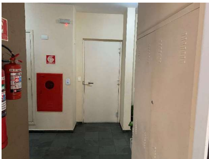
Foto 20 – Vista do acesso à escadaria de rota de fuga.
