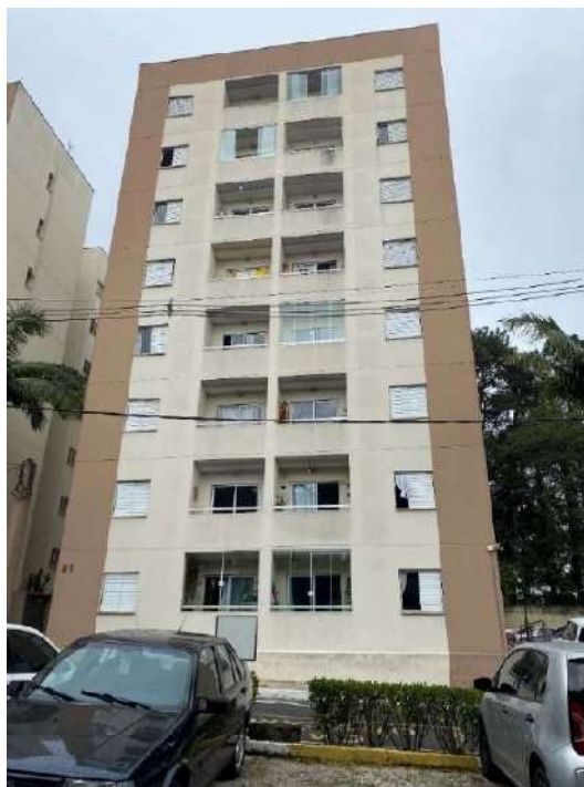
Foto 3 – Vista da fachada do edifício Paineira, onde está localizada o imóvel avaliando.
