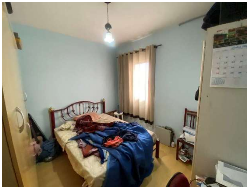
Foto 16 – Vista do dormitório I da unidade similar nº 71, apresentando os seguintes padrões construtivos: Piso laminado, alvenarias e teto revestidos em pintura látex PVA sobre massa corrida; esquadrias em alumínio e porta em madeira.
