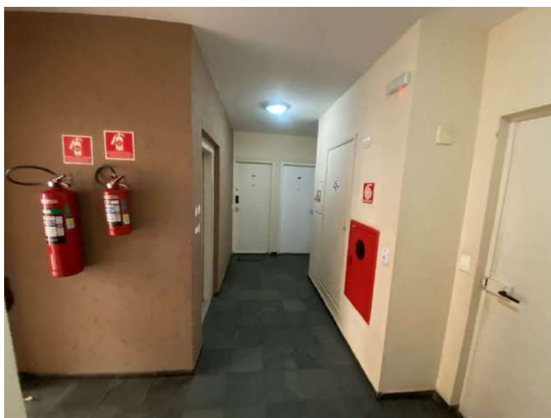
Foto 19 – Vista do hall de circulação dos apartamentos.
