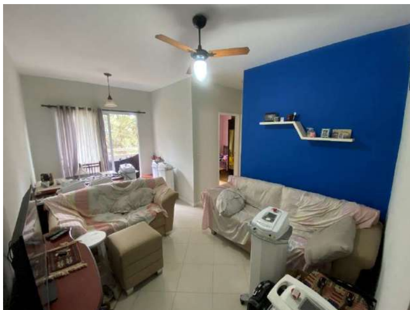
Foto 14 – Vista da sala da unidade similar nº 71, apresentando os seguintes padrões construtivos: Piso cerâmico, alvenarias e teto revestidos em pintura látex PVA sobre massa corrida; porta balcão em vidro e alumínio.
