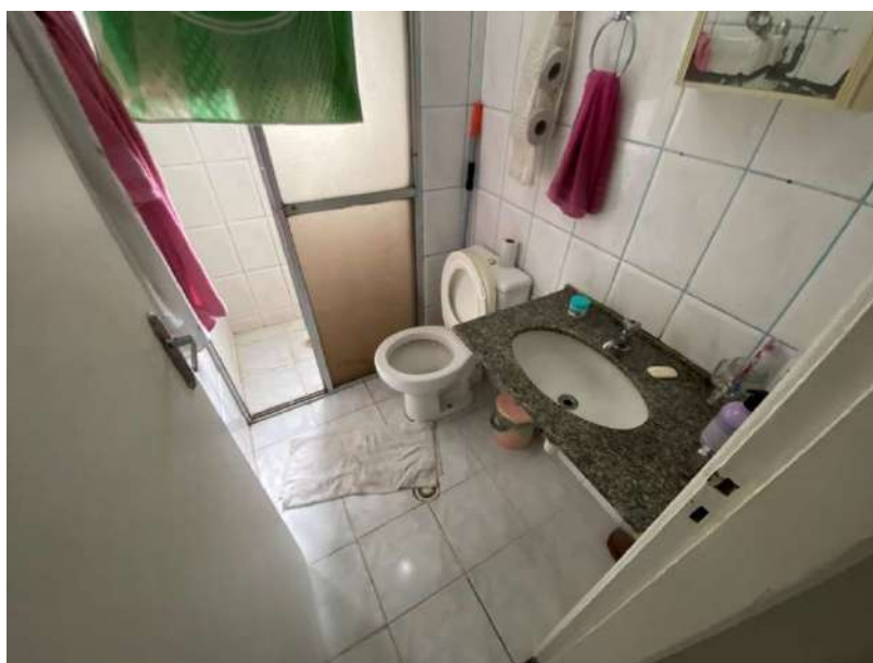
Foto 17 – Vista do banheiro da unidade similar nº 71, apresentando os seguintes padrões construtivos: Piso e alvenarias revestidos em cerâmica, teto revestido em pintura látex PVA sobre massa corrida e acabamentos em moldura de gesso; esquadrias em alumínio e porta em madeira.
