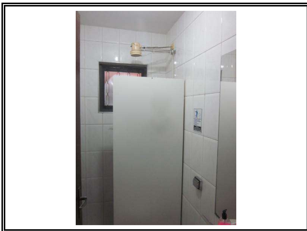
Fotos nº 26: Vista do banheiro no pavimento superior
