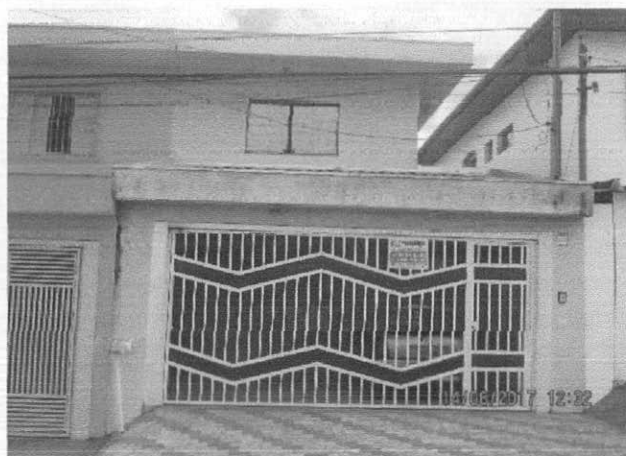
Foto Nº 04 – Vista Fachada Imóvel
