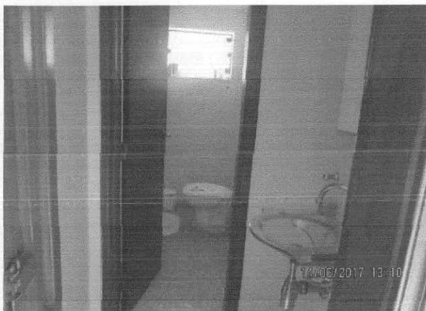
Foto Nº 13 – Vista WC Térreo
