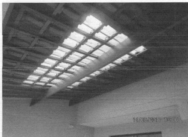
Foto Nº 07 – Vista Cobertura Garagem
