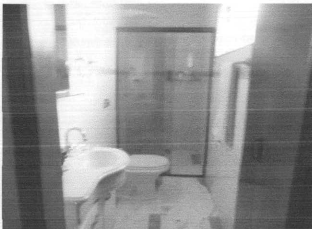
Foto Nº 25 – Vista Banheiro Suíte 2
