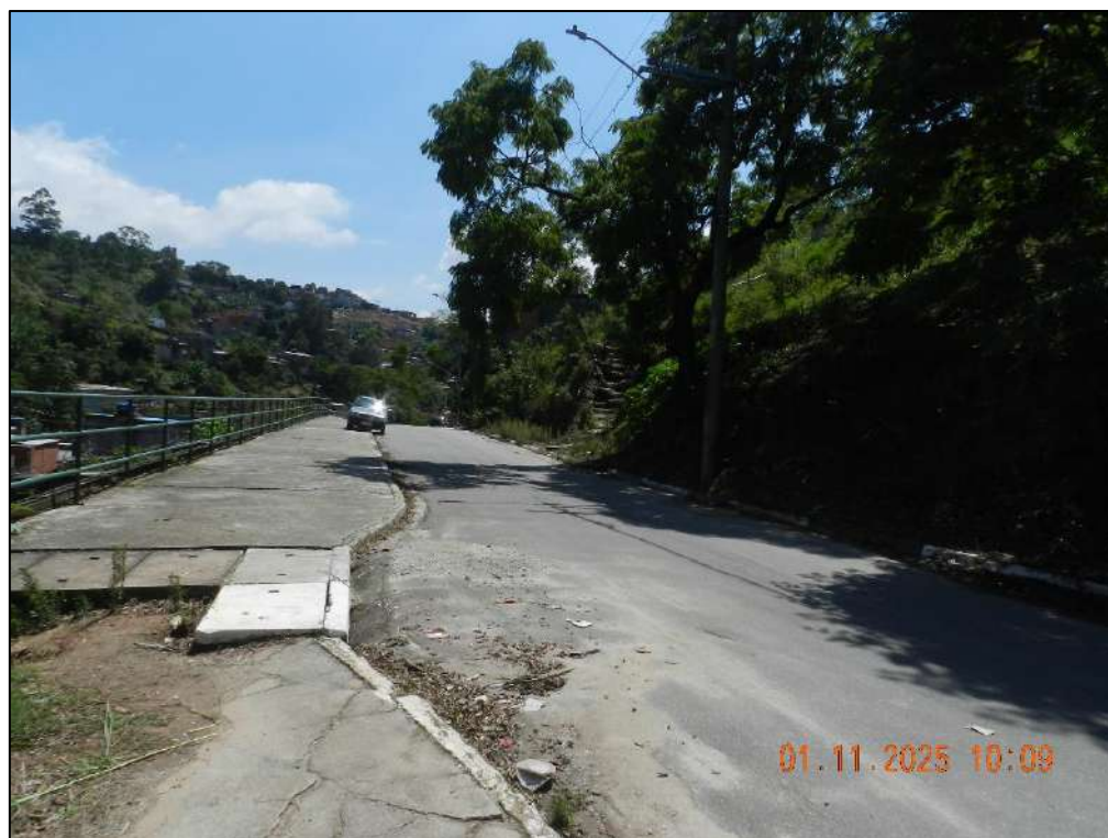
FOTOGRAFIA N° 01: Vista da Rua Clementino Pedroso de Siqueira, no trecho considerado.
