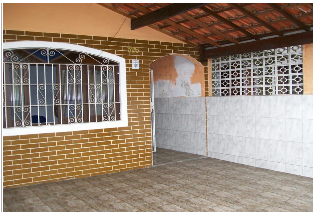
FOTO 04: - Outra vista complementa a FOTO 01, visando a notação do tipo construtivo do imóvel avaliando .
