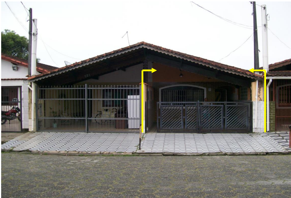
FOTO 01: - Vista do imóvel-objeto nº325 da Rua Margarida, no bairro Flórida, em Praia Grande /SP (metade ideal do lote nº 14 da quadra nº 11 – loteamento Jardim Princesa – Gleba II).
