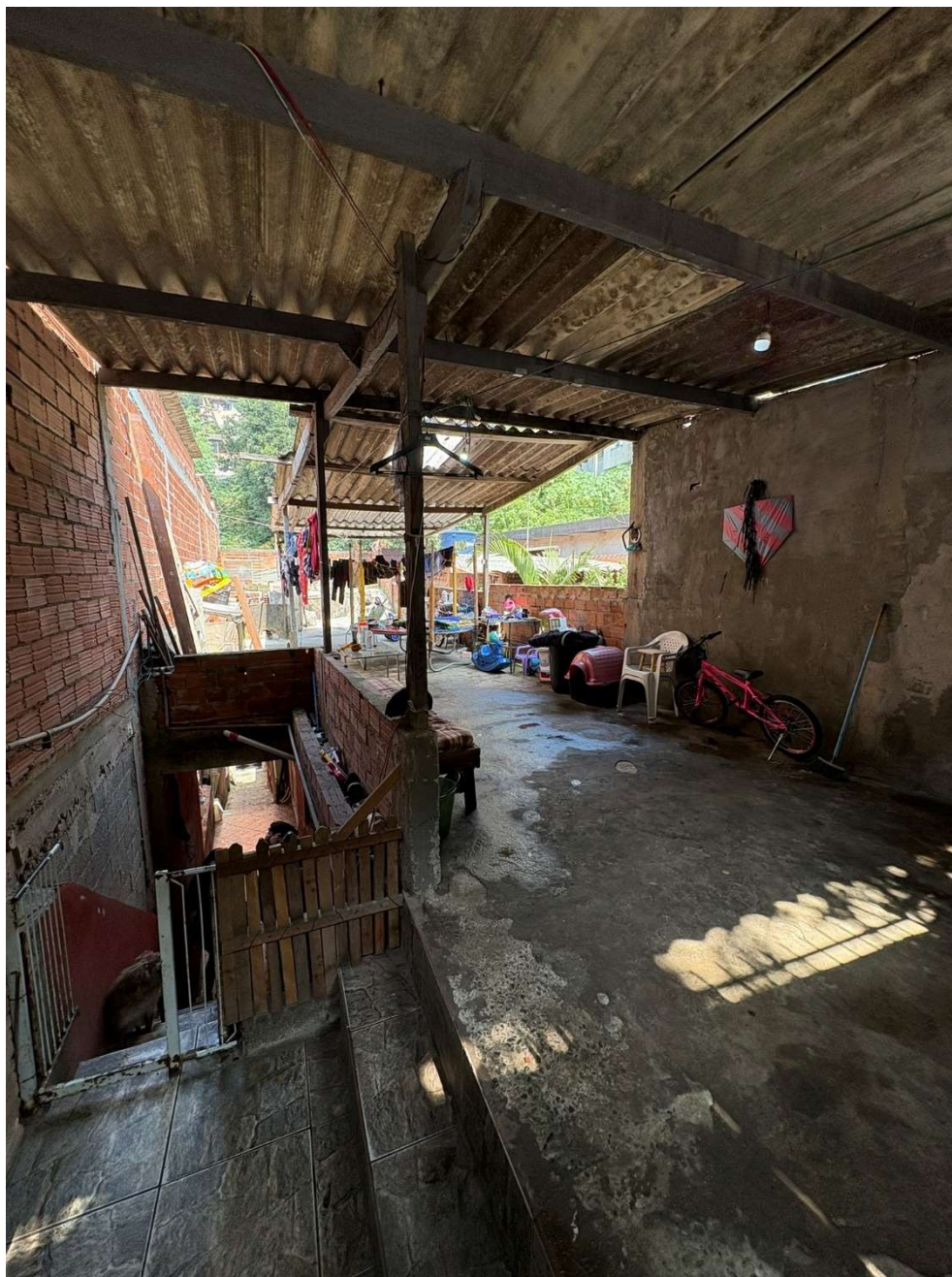
Figura 6: laje e escada de acesso
