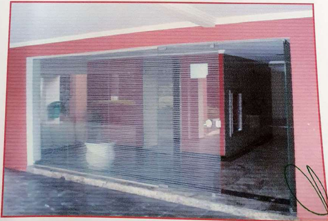
FOTO nº 06 Vista do hall social no térreo.
