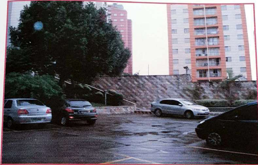
FOTO nº 07 Vista do estacionamento descoberto no térreo.
