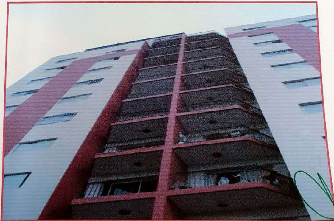
FOTO nº 04 Vista da fachada do Edifício Napoli.
