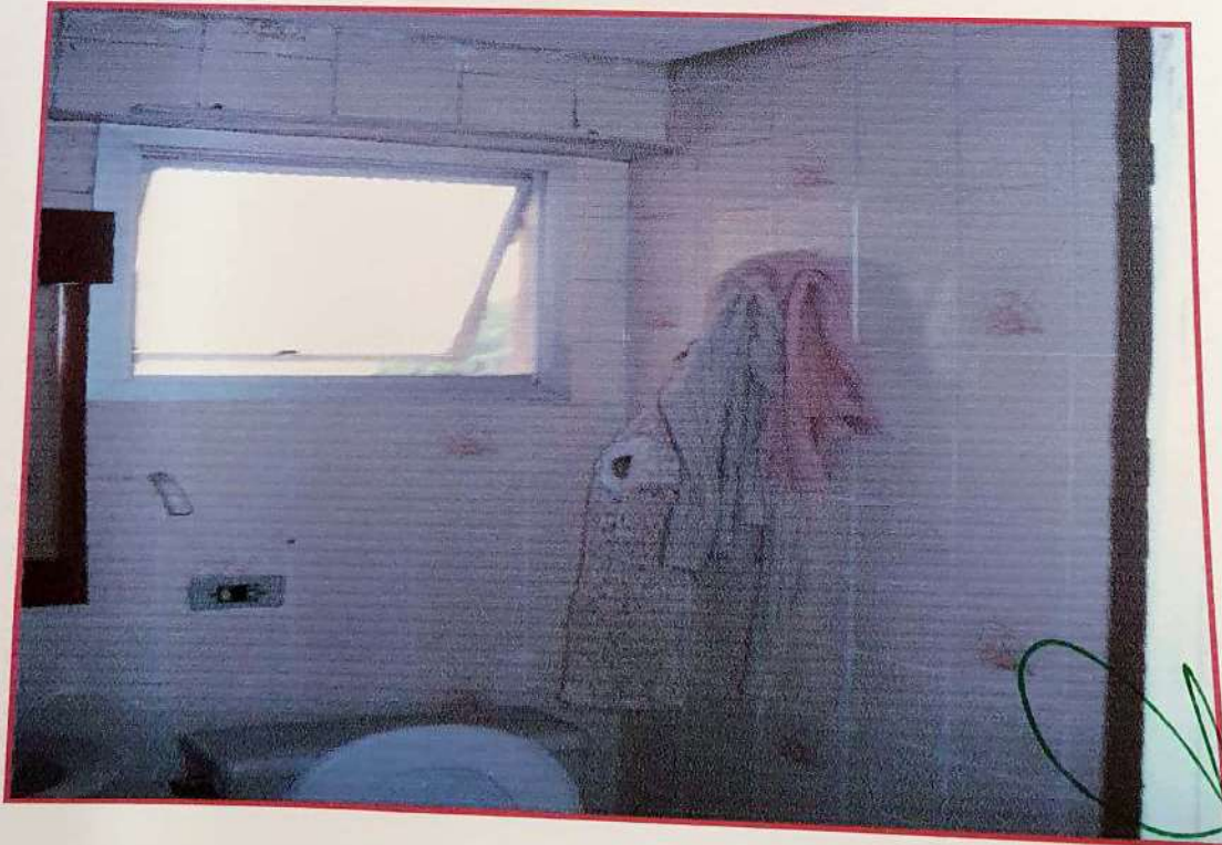
FOTO nº 18 Vista do banheiro social no apartamento avaliando.
