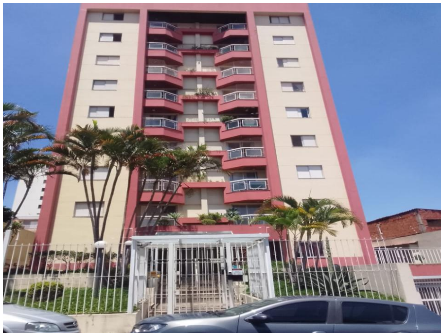
Vista da fachada do Condomínio Edifício Turquesa
