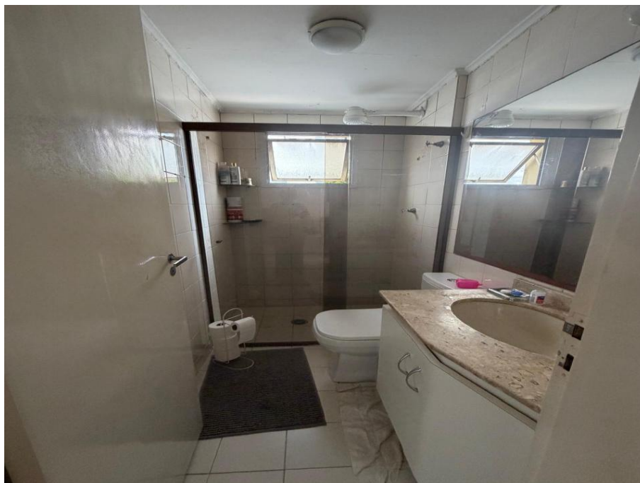
Banheiro do Apartamento 43 vistoriado
