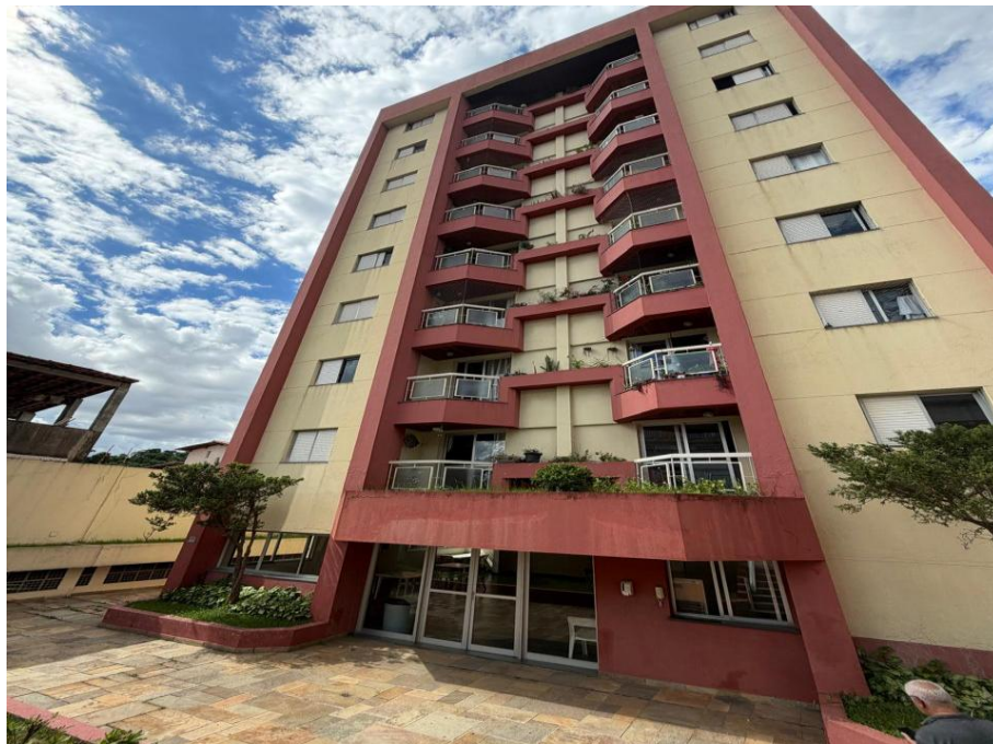
Vista dos fundos
