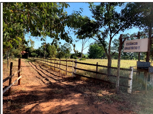
Foto 01. Vista geral da entrada ao imóvel
