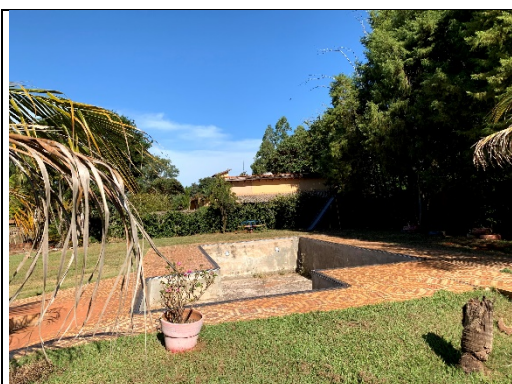
Foto 05. Vista da piscina desativada
