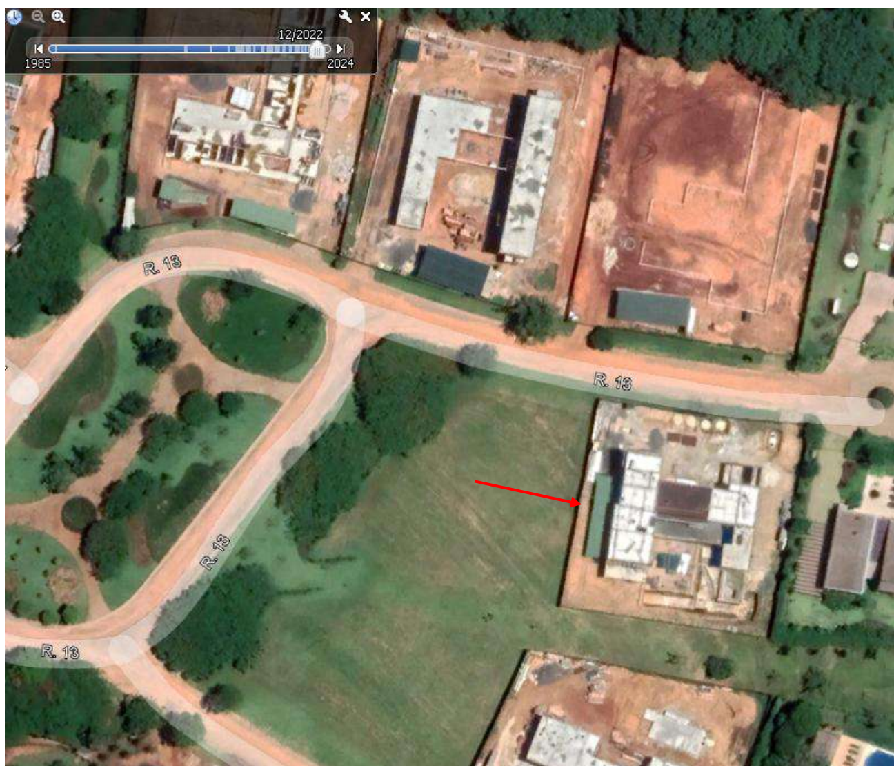
Figura 16 – Construção em dezembro de 2022
