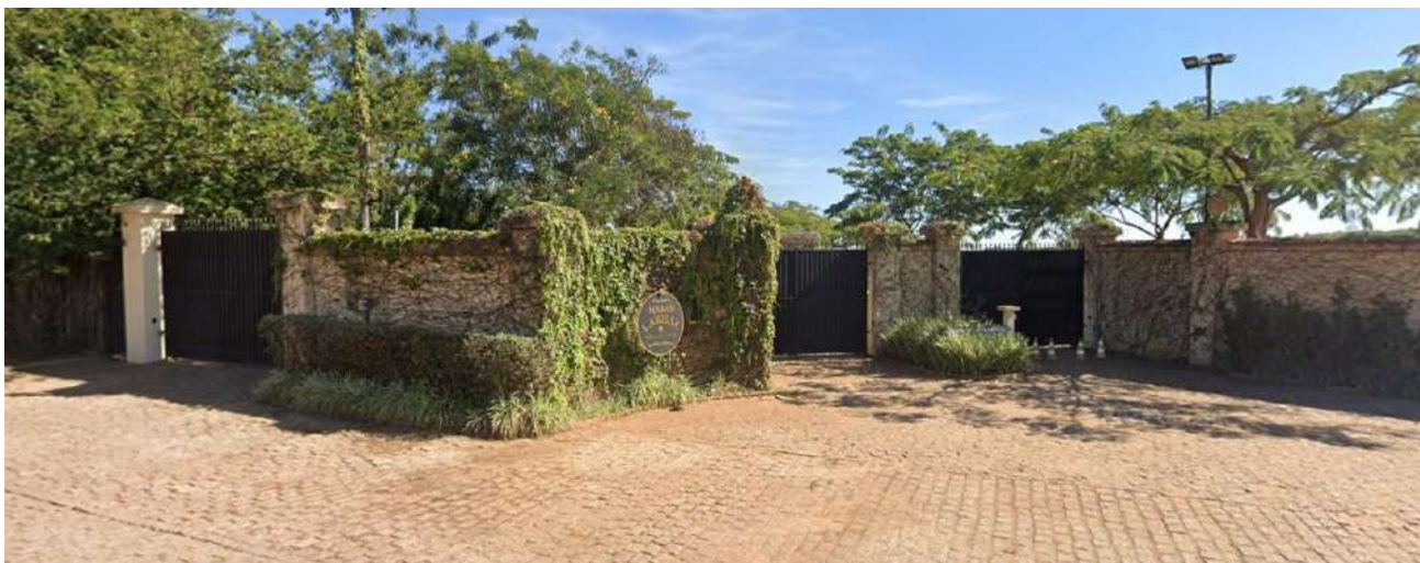
Figura 3 – Entrada social do condomínio
