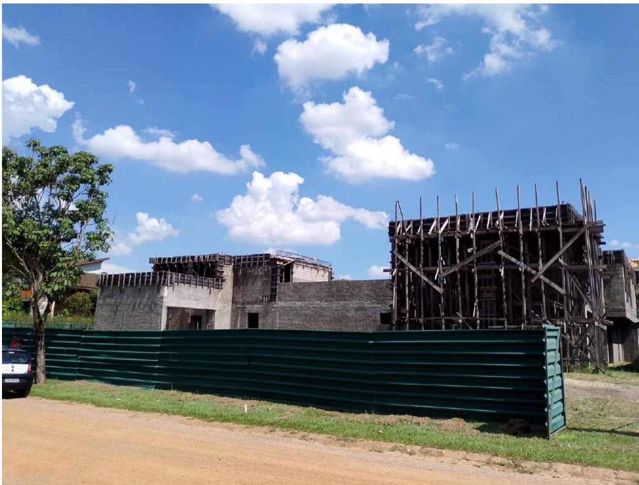
Figura 18 – Fachada do lote
