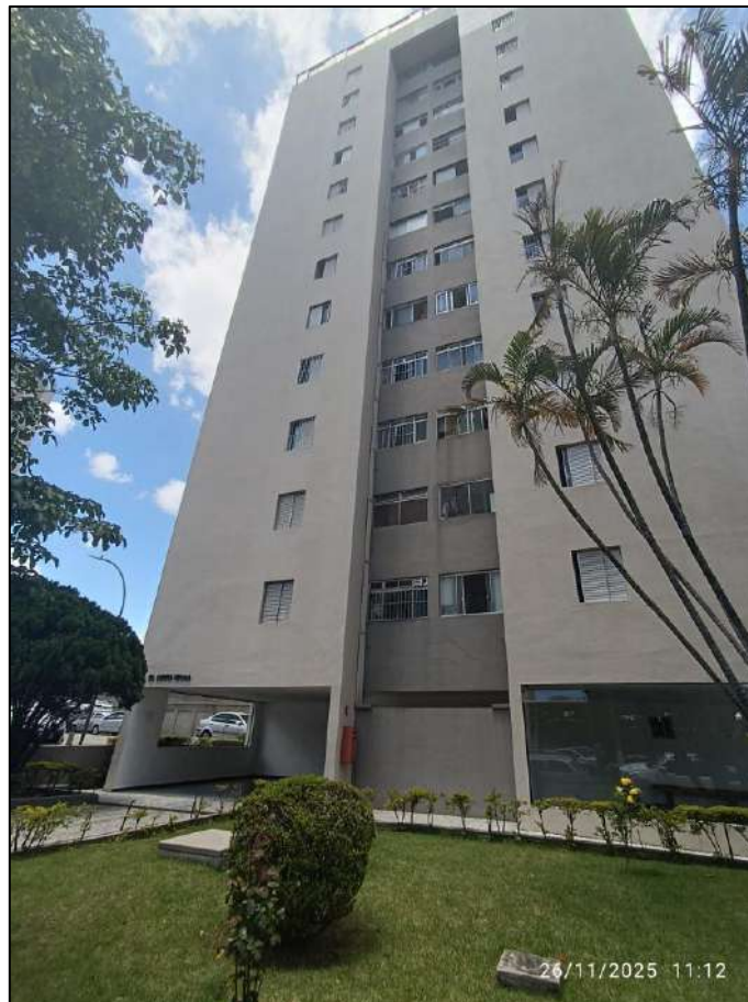
Figura 7. Vista do Edifício "Serra Negra" no qual se situa a unidade avalianda.
