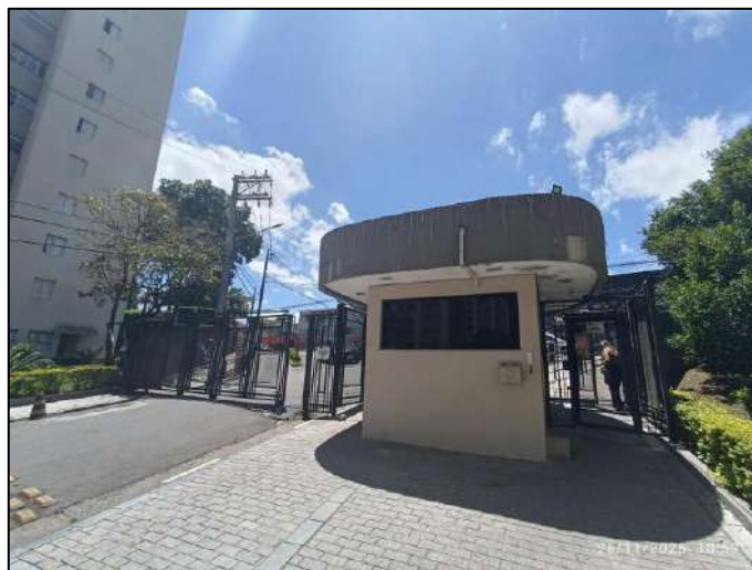
Figura 4. Vista da portaria do Condomínio Residencial Buena Vista.
