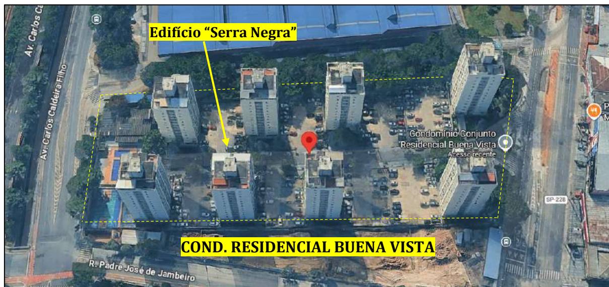
Figura 3. Identificação do Condomínio Buena Vista e do Edifício "Serra Negra" (Google Maps).
