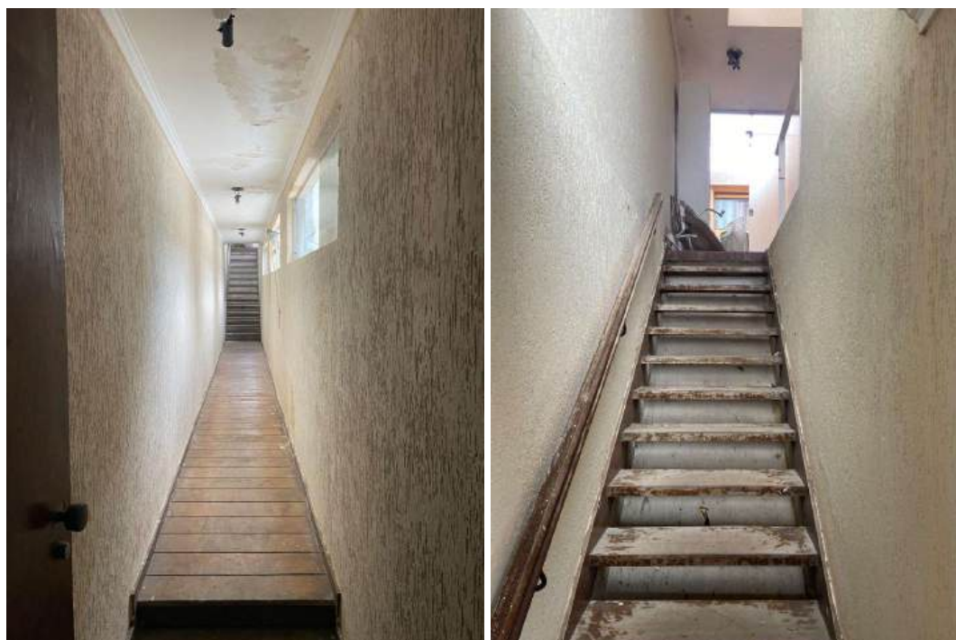
FOTO 14/16: Corredor lateral com vista para a piscina.
