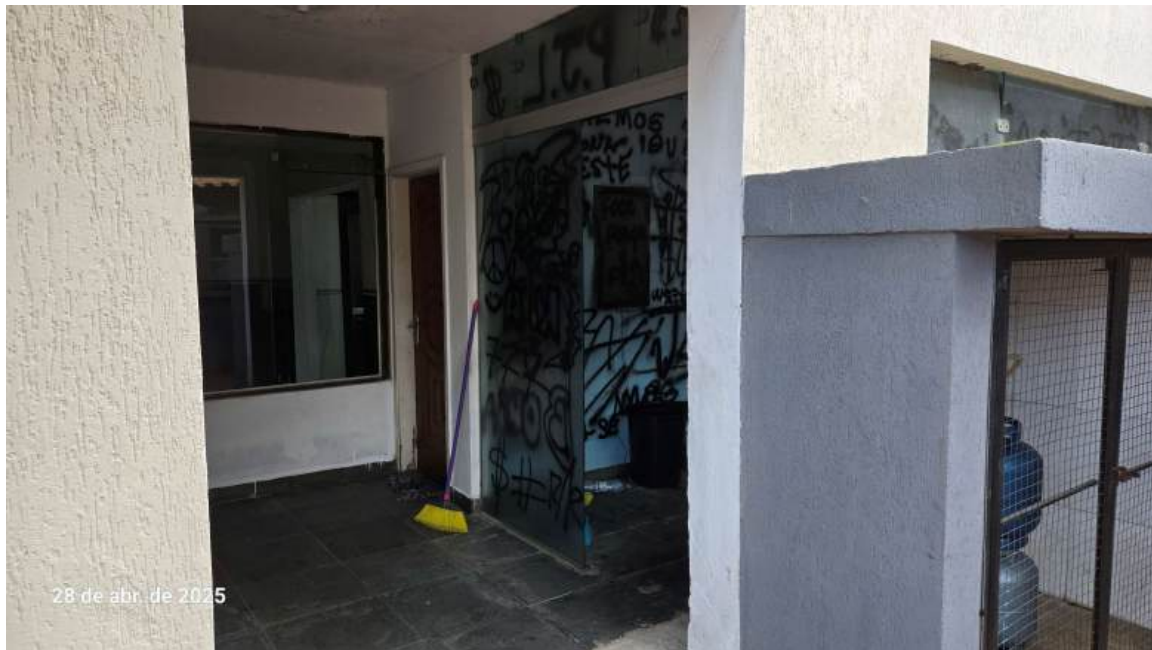
FOTO 46/47: Lavanderia (corpo principal).
