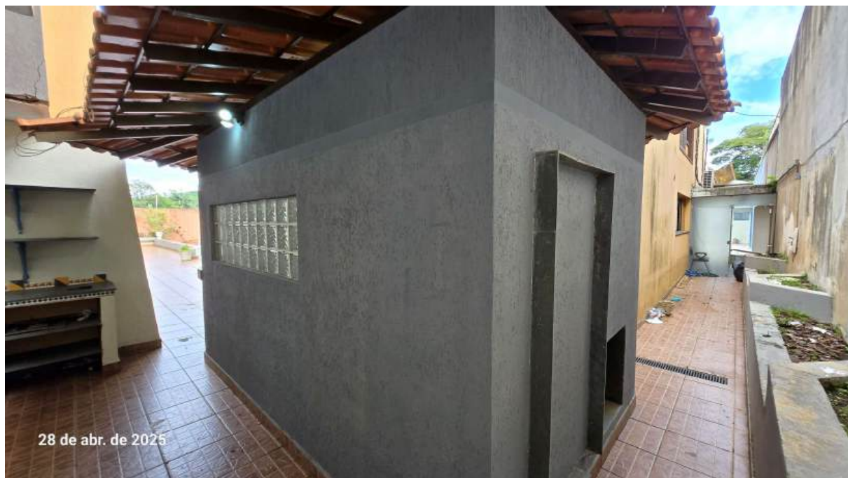
FOTO 17/22: Área externa dos fundos.
