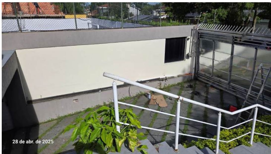
FOTO 06: Lateral direita do portão.
