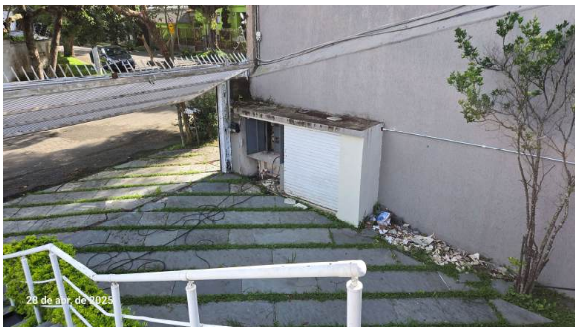
FOTO 05: Lateral esquerda do portão.
