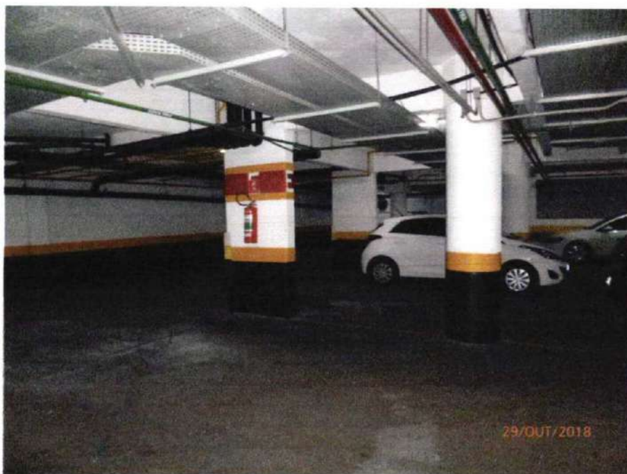
Foto nº. 15 – Outra vista parcial do subsolo.
