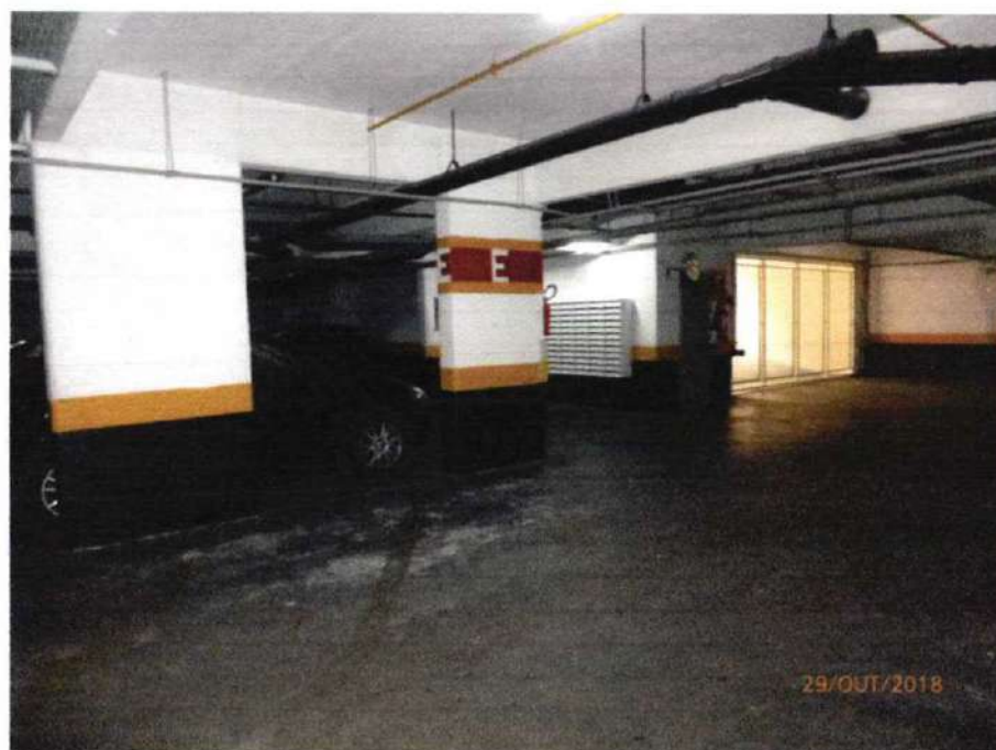
Foto nº. 14 – Vista parcial do subsolo.
