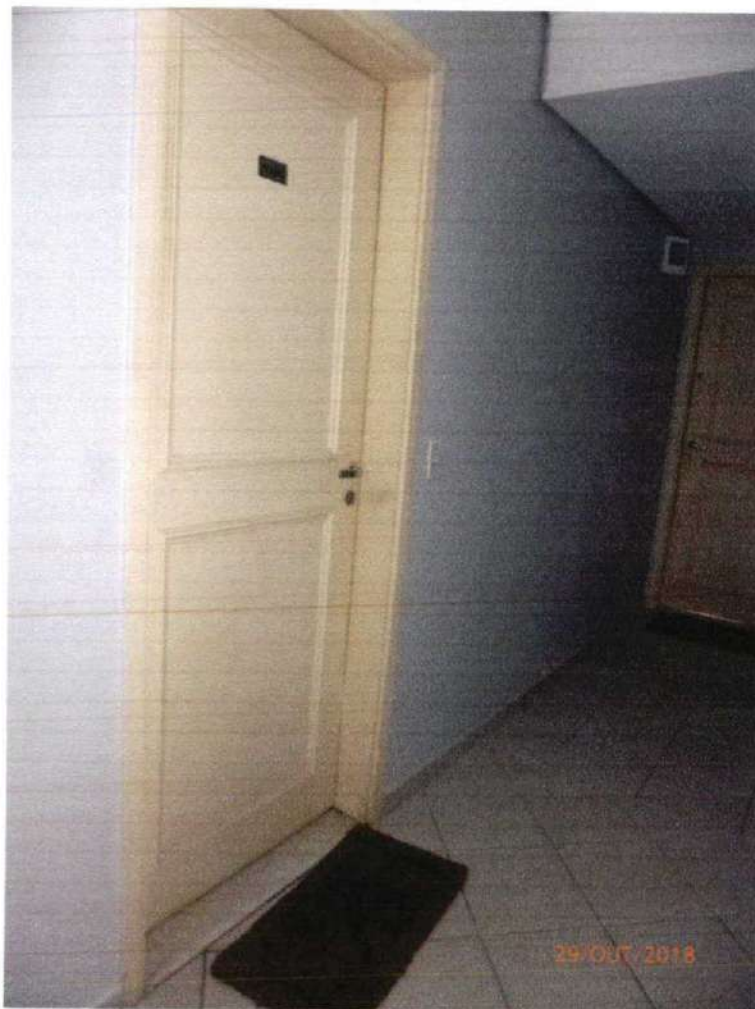
Foto nº. 17 – Vista da entrada do apartamento nº 808A, avaliado no presente laudo.
