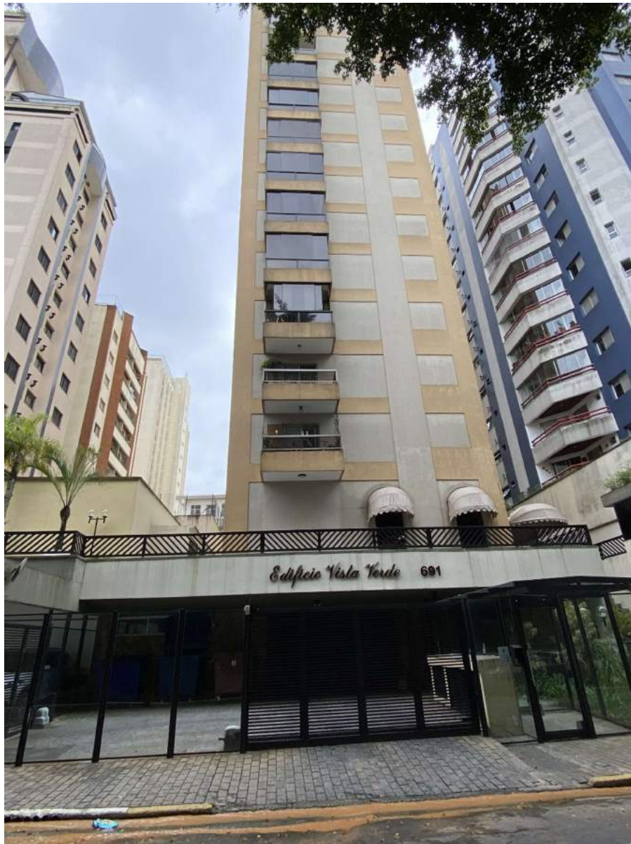
ASPECTOS GERAIS FACHADA
