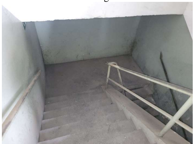
09 escada de acesso ao segundo andar
