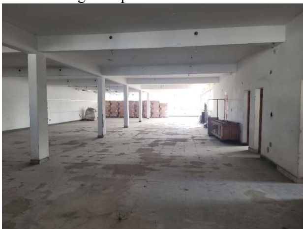
16 vista segundo piso
