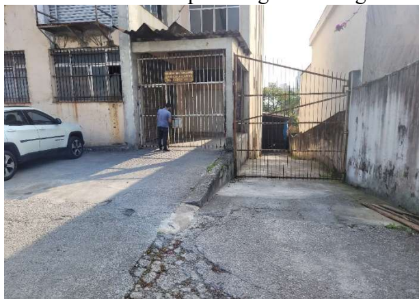
02 fachada e entrada para carga e descarga
